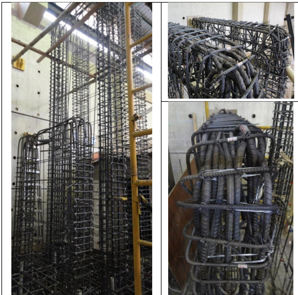
FIGURA 4.1: Armado de losa de anclaje y Muros M1, M2, y M3
