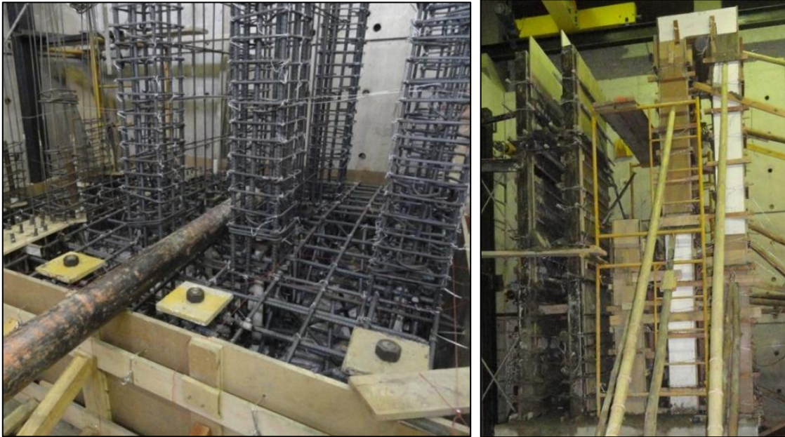
FIGURA 4.3: Hormigonado de la losa de anclaje y muros M1, M2 y M3
