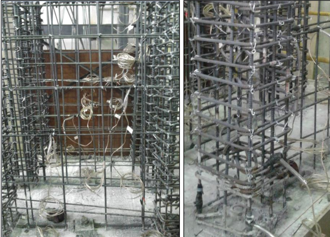
FIGURA 4.2: Colocación de Strain Gauges
