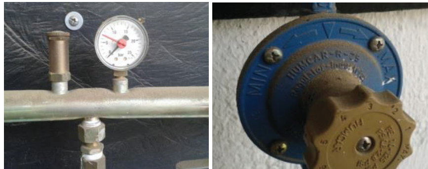
Figura 3. 2 (a) Fig de la izquierda Medidor de Presión; (b) Fig de la derecha Válvula reguladora de paso de gas
