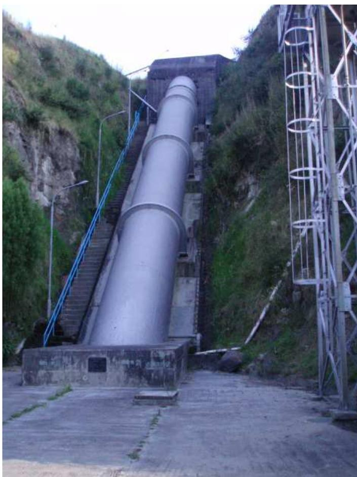
FOTOGRAFÍA 2.8 Tubería de presión de la C/H Guangopolo para la Casa de Máquinas Nueva
