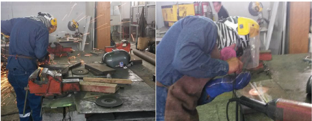
Figura 3.29.- Limpieza de la junta en cada pase
