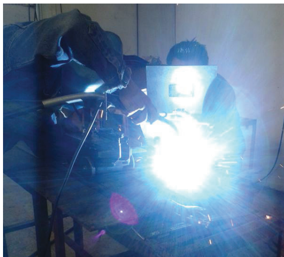
Figura 3.24.- Soldadura de la probeta de calibración
