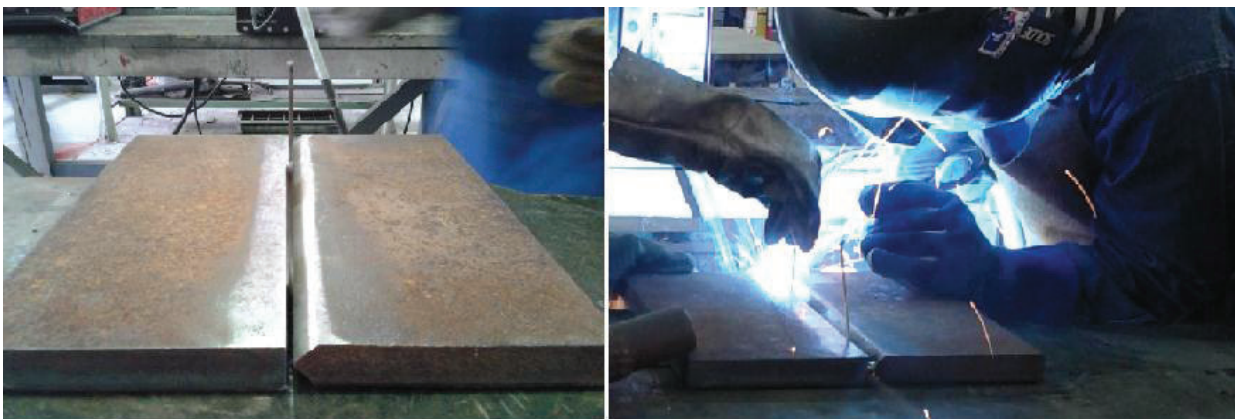
Figura 3.26.- Alineación de la junta tipo K con una separación entre placas de 3 [mm]
