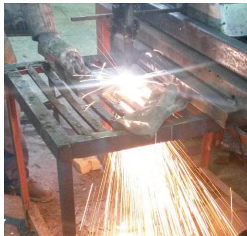
Figura 3.14.- Desprendimiento del metal de corte por acción del chorro de O_2
