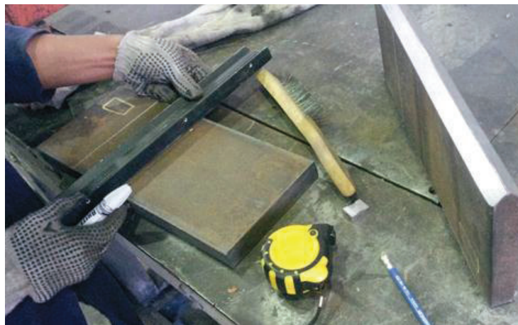
Figura 3.10.- Trazo de líneas de referencia
