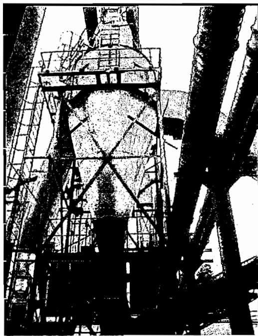
Figura 5.33 Cono donde se separa el gas caliente del material seco (Novopan del Ecuador S. A. 2004).
