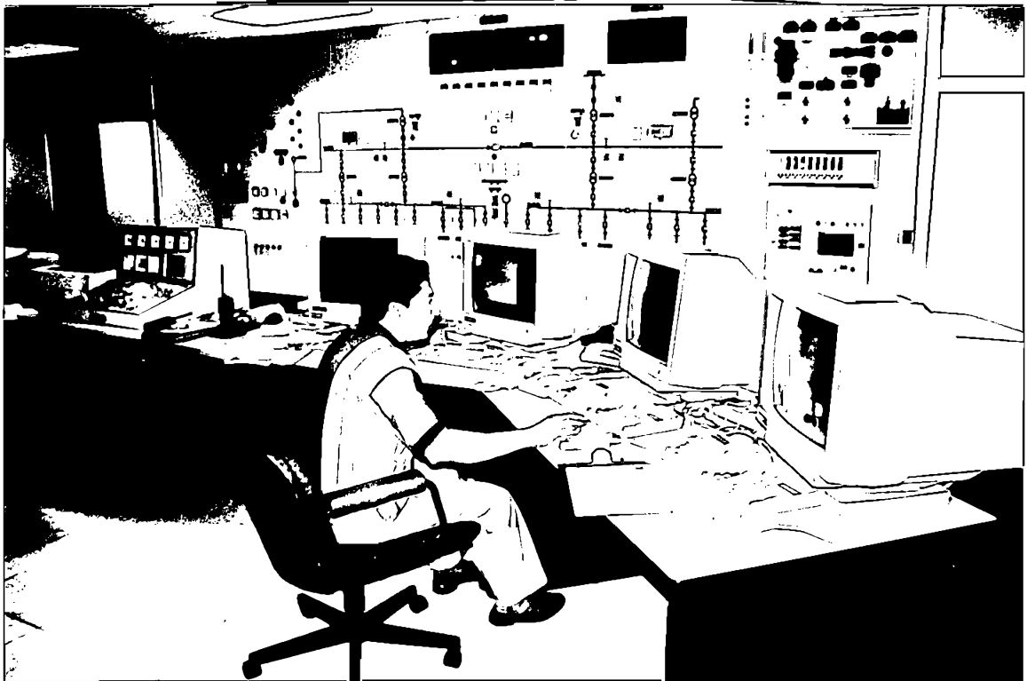
Foto 4. Consolas del Sistema de control distribuido
