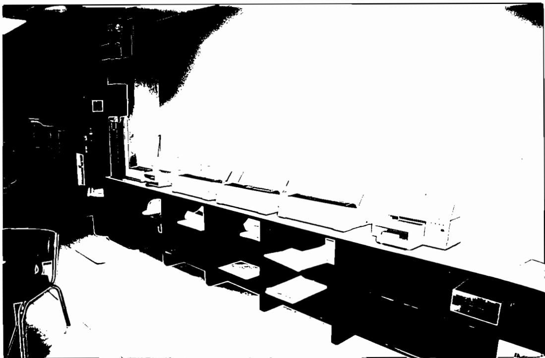
Foto 6. Estación de impresoras de reportes y líneas de tendencia
