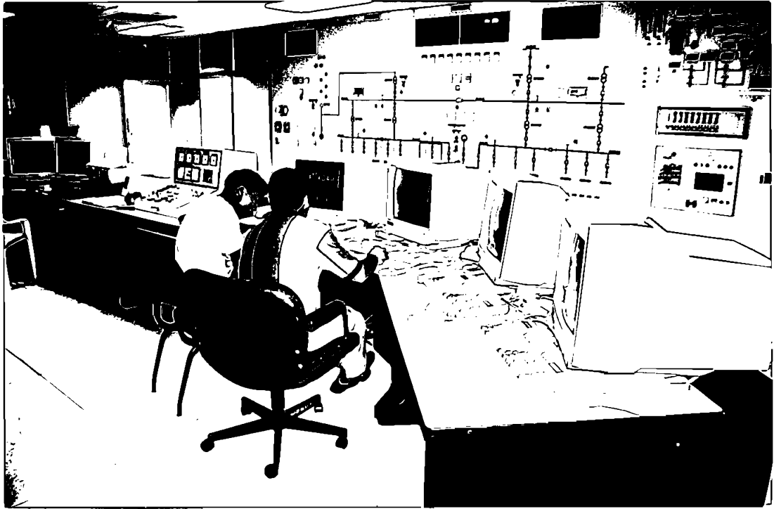
Foto 3. Sala de Control
