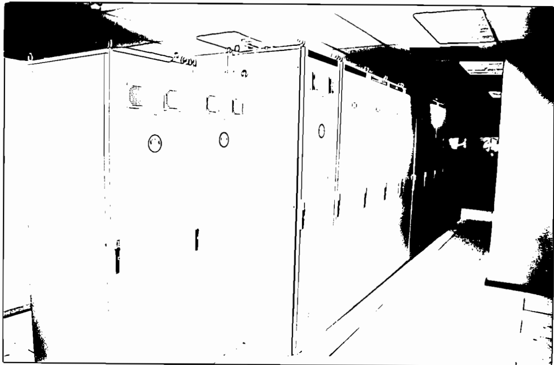
Foto 13. Vista frontal de los gabinetes del sistema de control distribuido
