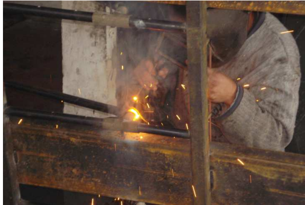
Fotografía 6.5: Montaje de sistema de sujeción.
