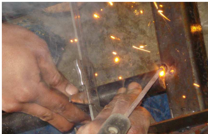
Fotografía 6.6: Montaje de flauta (sistema de sujeción).
