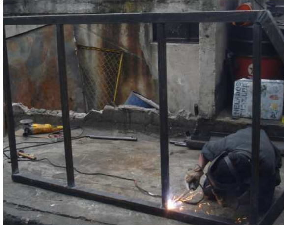
Fotografía 6.2: Montaje de Bastidor.
