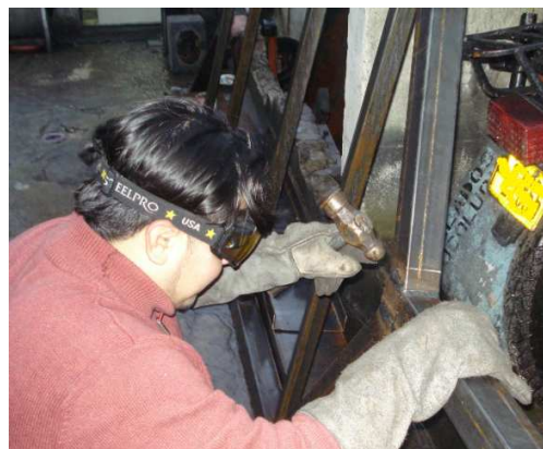
Fotografía 6.3: Montaje de sistema de tiro.
