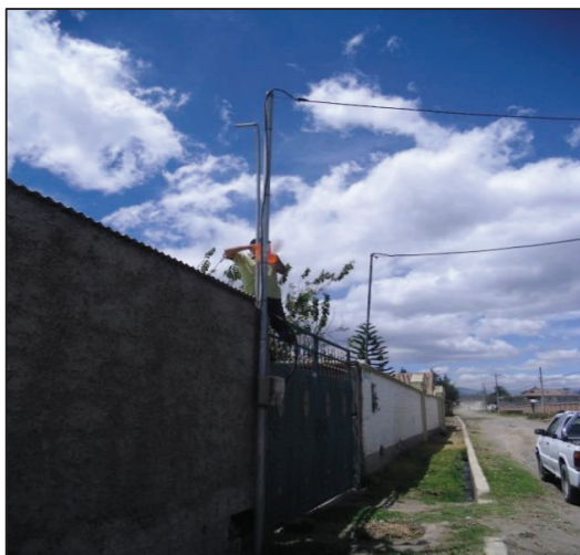
Fotografía No. 30: Colocación de muestreadores
