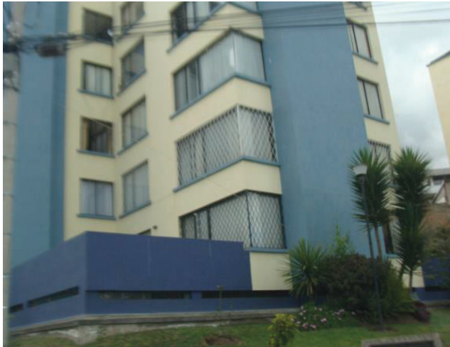
FIGURA 1.4 Edificio residencial en la ciudad de Quito, presenta columna corta.
