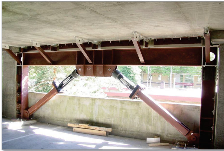
FIGURA 2.19 AMORTIGUADORES SÍSMICOS
