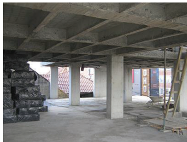
FIGURA 1.10 LOSA APOYADA SOBRE VIGAS DESCOLGADAS.
