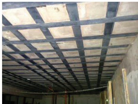
FIGURA 2.18 REVESTIMIENTOS CON FIBRA DE CARBONO
