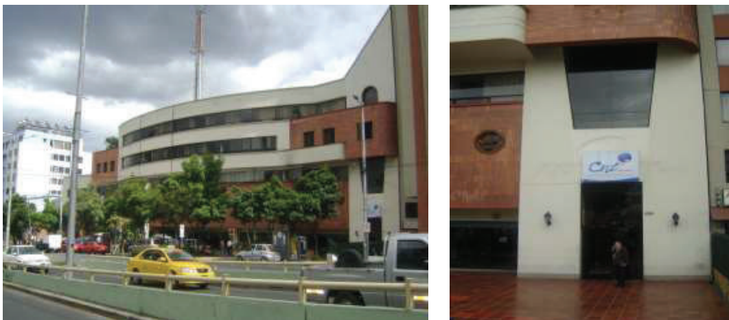
Figura 3.9. Acceso secundario al edificio Plaza Doral
