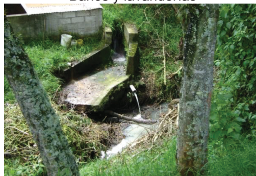
Descarga alcantarillado a la quebrada
