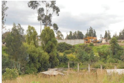
Proceso de Urbanización
