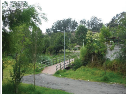
FOTOGRAFÍA N° 5 Entrada Pto-03, El Tingo
