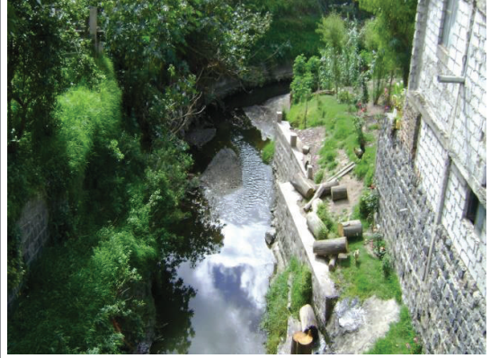
FOTOGRAFÍA N° 14 Pto-07, Av. Ilaló - Hornados Doña Rosa
