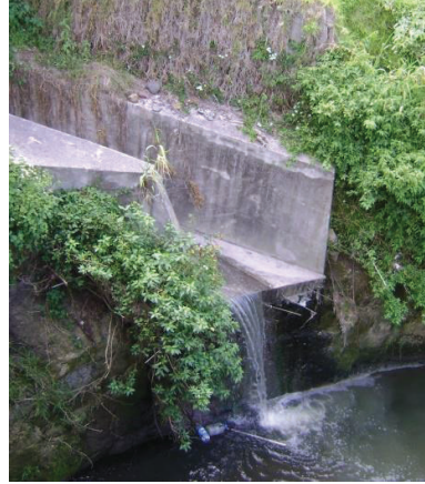
FOTOGRAFÍA N° 16 AR-01, Descarga alcantarilla San Carlos
