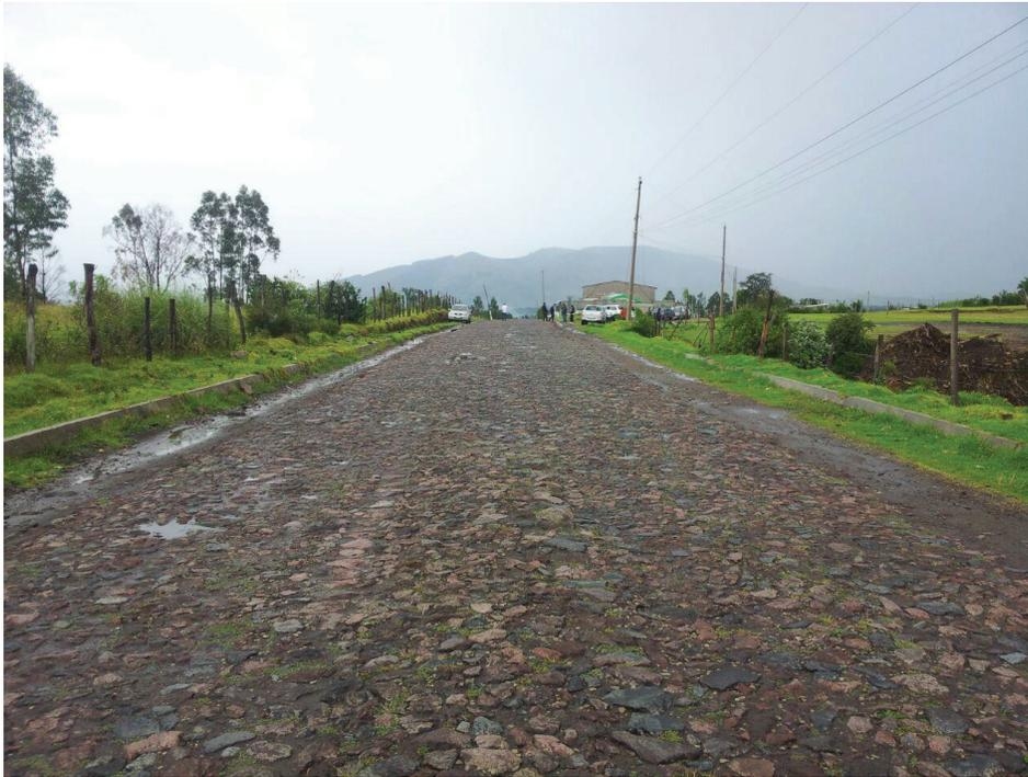
**Vía de pruebas con superficie de rodadura empedrada.**
