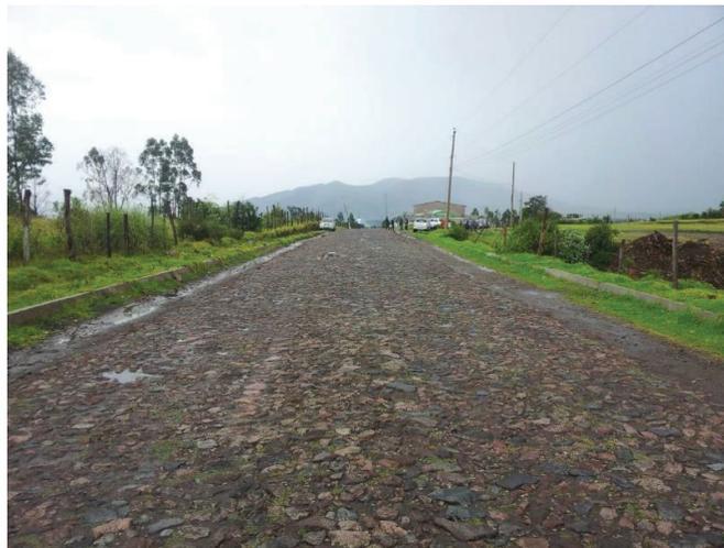
**Figura 3.10 Vía de pruebas con superficie de rodadura empedrada.**
