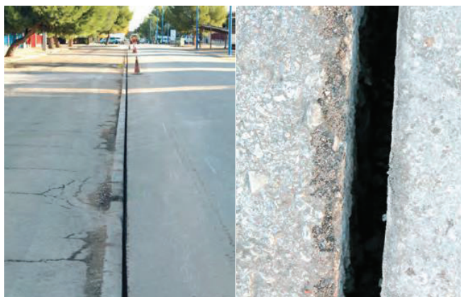
Figura 2.6 Calidad del corte de la microzanja y detalle del mismo. [53]
