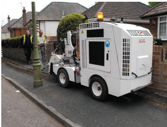
Figura 2.5 Equipo de zanjadora con aspirador. [53]
