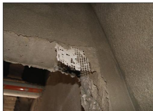
A través de la mampostería se extienden diferentes instalaciones como bajantes sanitarios, tuberías de agua potable y conexiones eléctricas (Fotografía 2.6). Por otra parte, sobre los huecos de puertas se fundió en sitio dinteles de 10 cm de alto como se muestra en la Fotografía 2.7. De la misma manera se fundió cornisas sobre antepechos de ventanas y algunos elementos de fachada que cuelgan de la losa.
