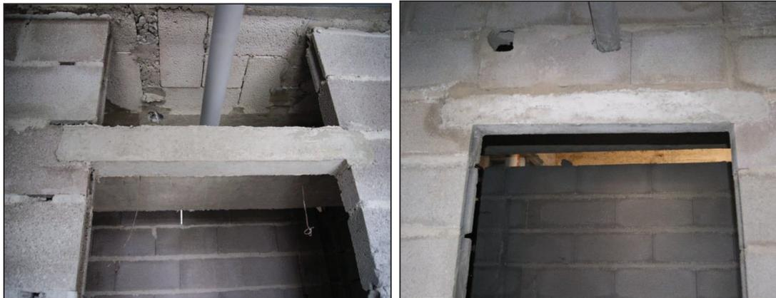
Sobre la mampostería de bloque se enlució con arena cernida en mezcla sencilla con cemento (Fotografía 2.8). Los espesores de enlucido están alrededor de los tres milímetros en zonas secas y hasta cinco milímetros en zonas húmedas. Finalmente, en los casos para los cuales no hay cerámica en paredes el enlucido se recubrió por el pasteado y de manera final por la capa de pintura.
