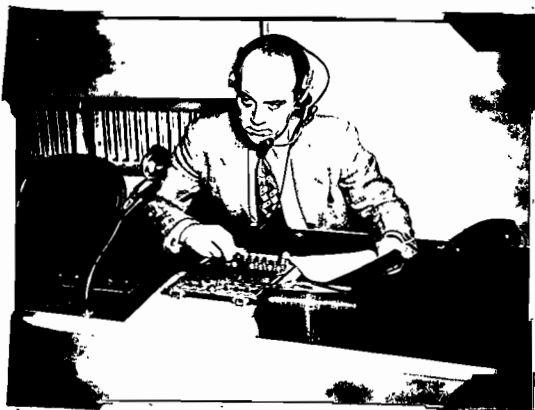
Fig.1-71:Tablero de control del director técnico; tiene a su disposición sistemas de comunicación de toda clase para comunicarse con cualquier sección (micrófonos, teléfono, sistema de intercomunicación por AF); maneja los interruptores. (Cortesía WSYR-TV).
