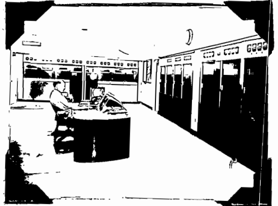
Fig. 1-18: Transmisor nuevo de 25KW a la derecha; al fondo está el antiguo de 5KW, ahora usado como auxiliar en WTMJ-TV (cortesía The Milwaukee Journal).
