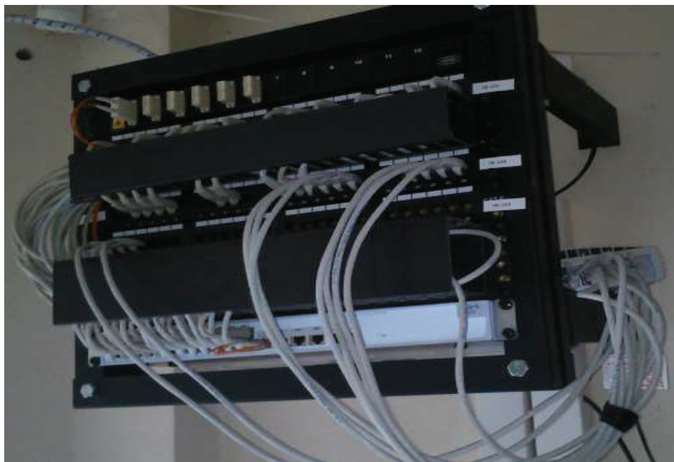
Figura 2.25 Rack de pared del laboratorio de Informática de Pre Básico.
