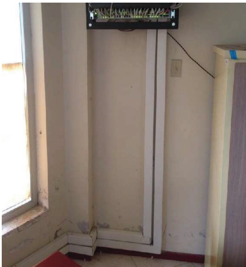
Figura 2.19 Cableado horizontal
