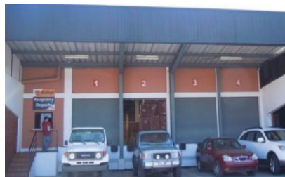
Figura 1.10 Andenes de carga de mercancías para clientes Fuente: Baldosines Alfa S.A.
