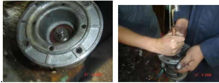
Figura A1.71 Desmontaje eje y fundas de reductor
