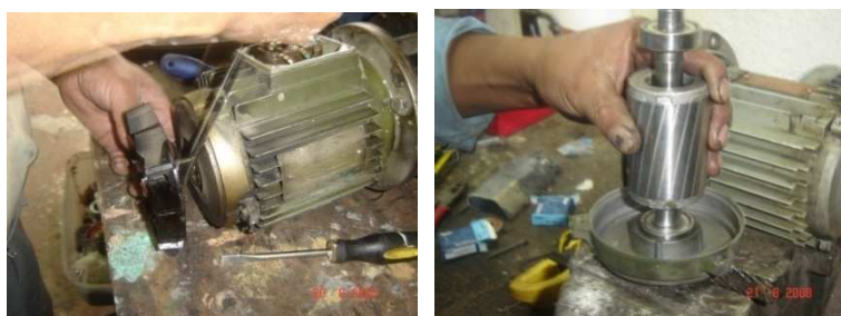
Figura A1.96 Desmontaje de motor
