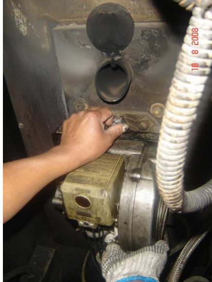
Figura A1.60 Desmontaje quemador del horno
