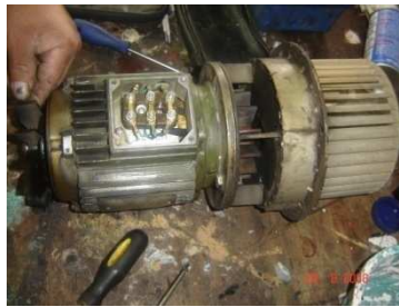
Figura A1.78 Desmontaje motor succión gases
