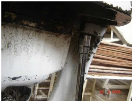
Figura A1.25 Aflojar tuercas de base
