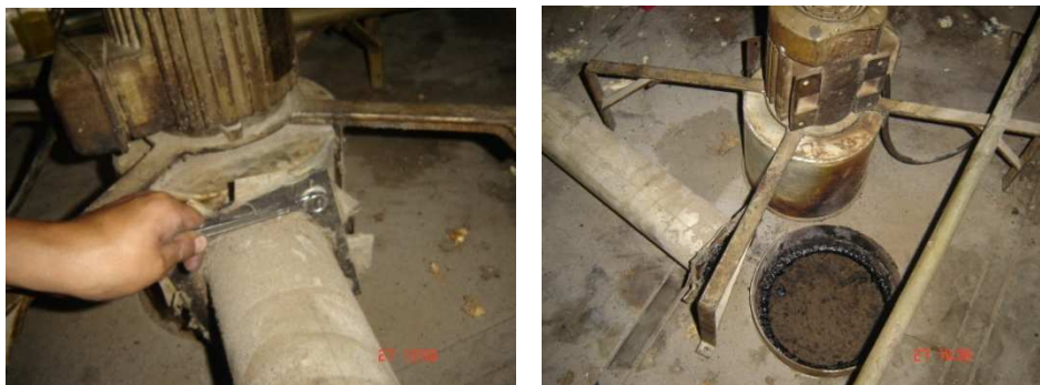
Figura A1.93 Desmontaje de la parte superior del horno
