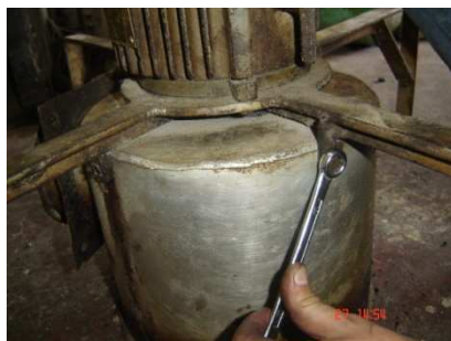
Figura A1.94 Desmontaje de estructura de acople
