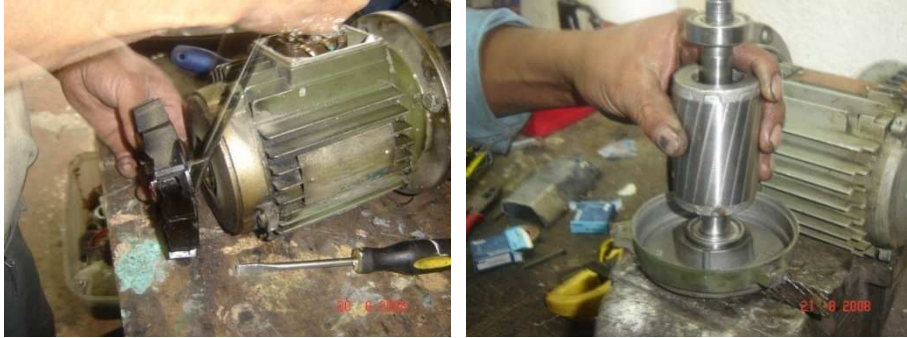
Figura A1.207 Desmontaje motor
