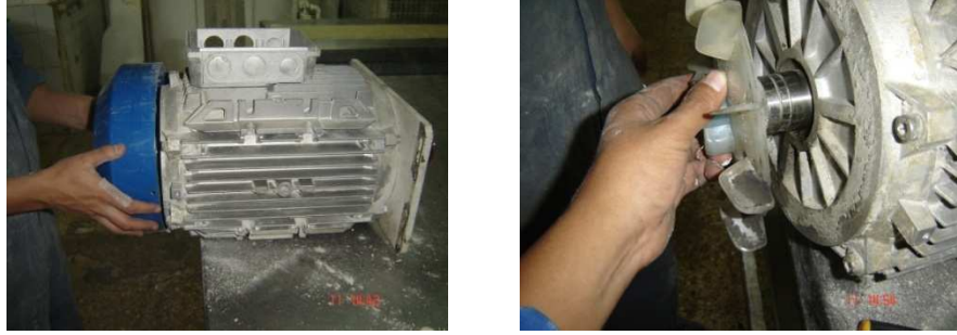
Figura A1.17 Desmontaje tapa y ventilador
