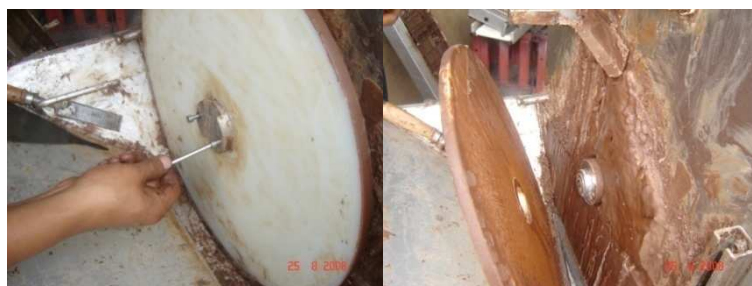
Figura A1.145 Desmontaje rodete
