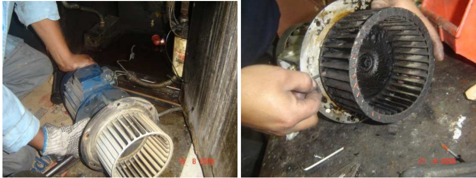
Figura A1.82 Desmontaje de rodete soplador
