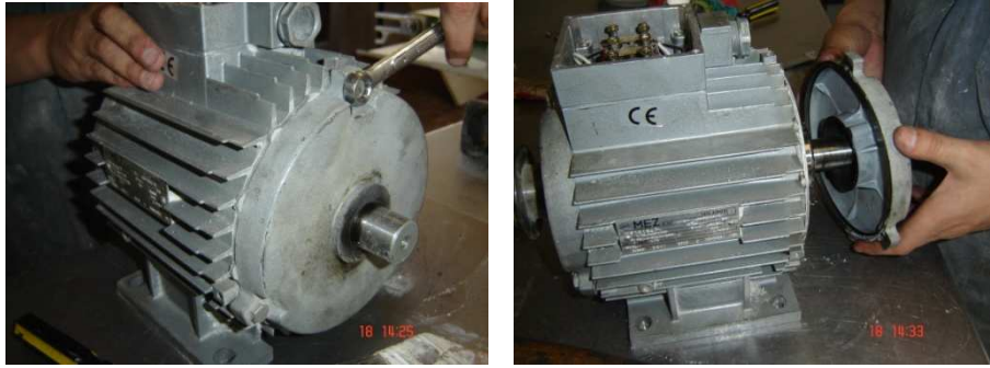
Figura A1.170 desmontaje rotor y estator
