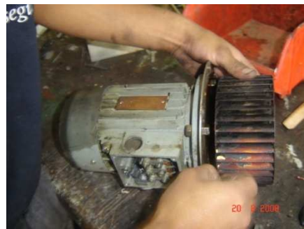
Figura A1.79 Retiro de rodete extractor
