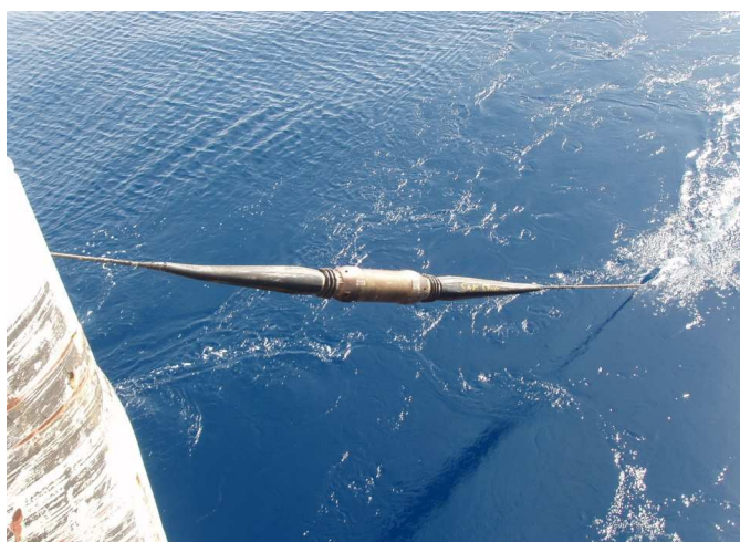
Fig. 23 Repetidor utilizado en la instalación
