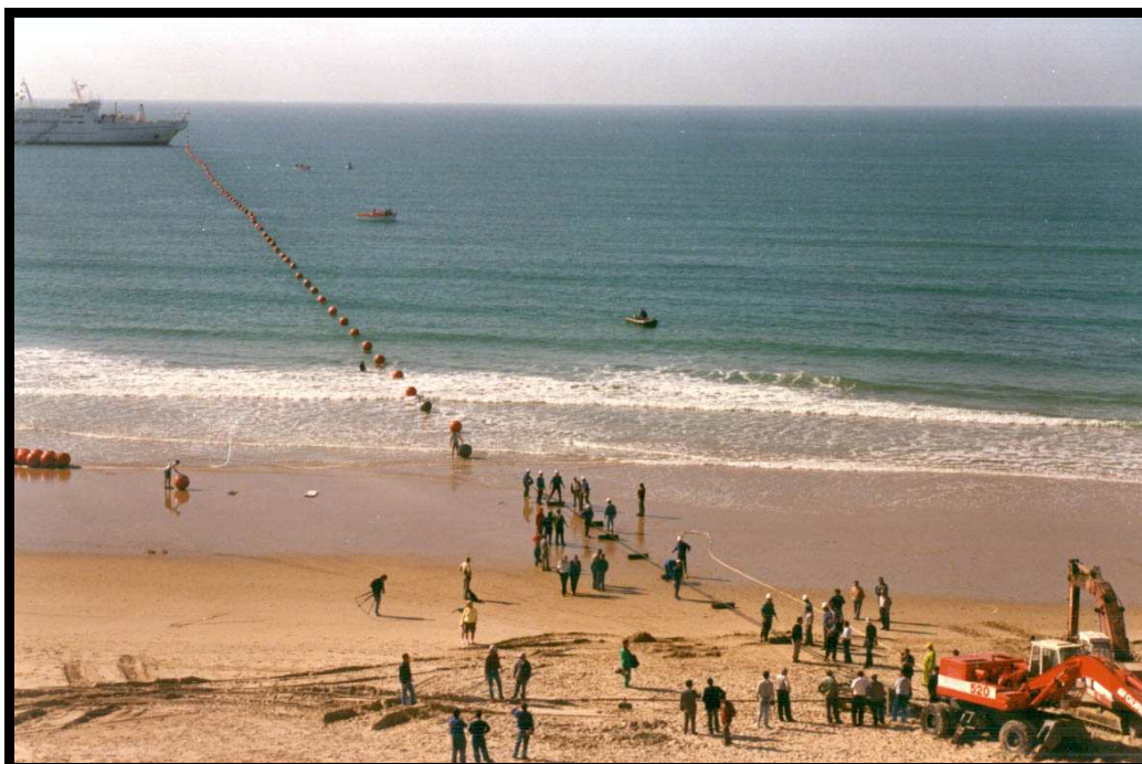
Fig.16 Imagen del tendido del cable partiendo desde Punta Carnero
