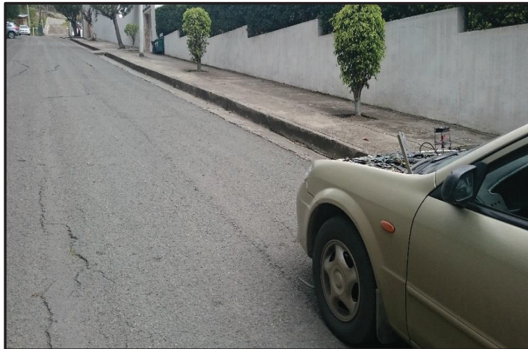
Figura 4. 10 Prueba vía de asfalto.
