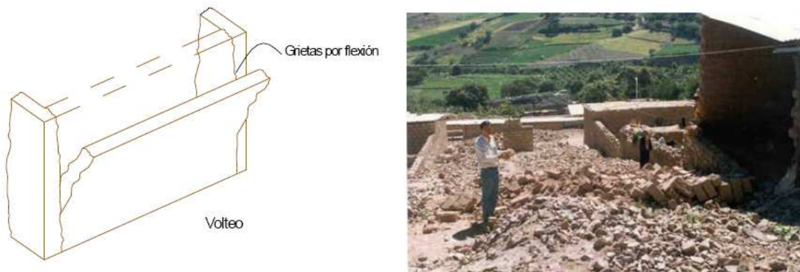
Figura 1-8 Falla por volteo (izq.) Colapso de muro por volteo (der.)
