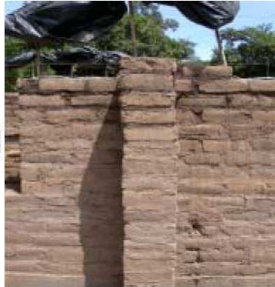
Figura 4-15 Edificación de Adobe con Contrafuertes y Pilastras en El Salvador.
