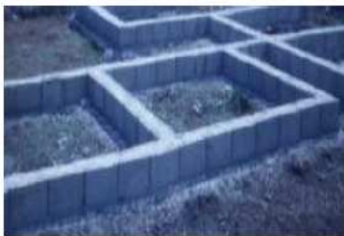
Foto 2.- Cimentación de la escuela
