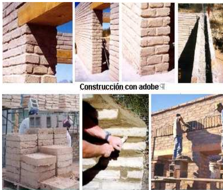
Figura 2-6 Construcción con adobe
