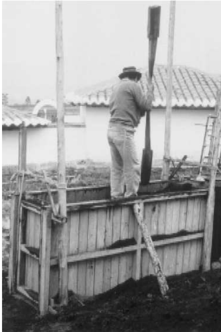
Figura B-4 Pisón de dos cabezas empleado en Ecuador.
