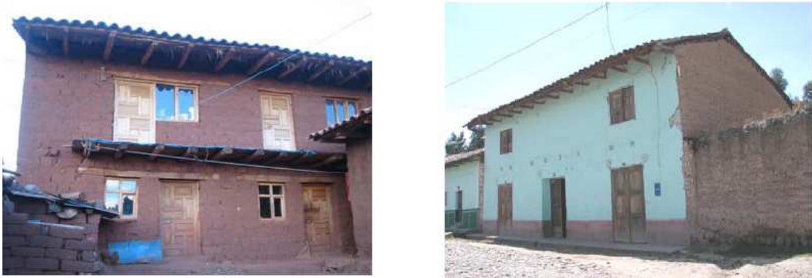
Figura 1-2 Vivienda representativa de adobe (izq.) y de tapial de dos pisos (der.)
