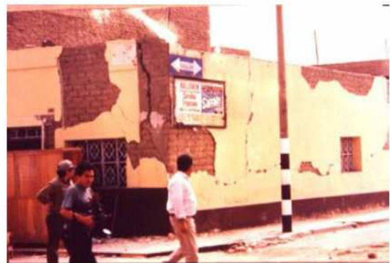
Figura 1-6 Falla por flexión en las esquinas (izq.) Vivienda con fallas de flexión (der.)
