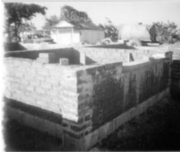
Foto 3.- Levantamiento de los muros de adobe
