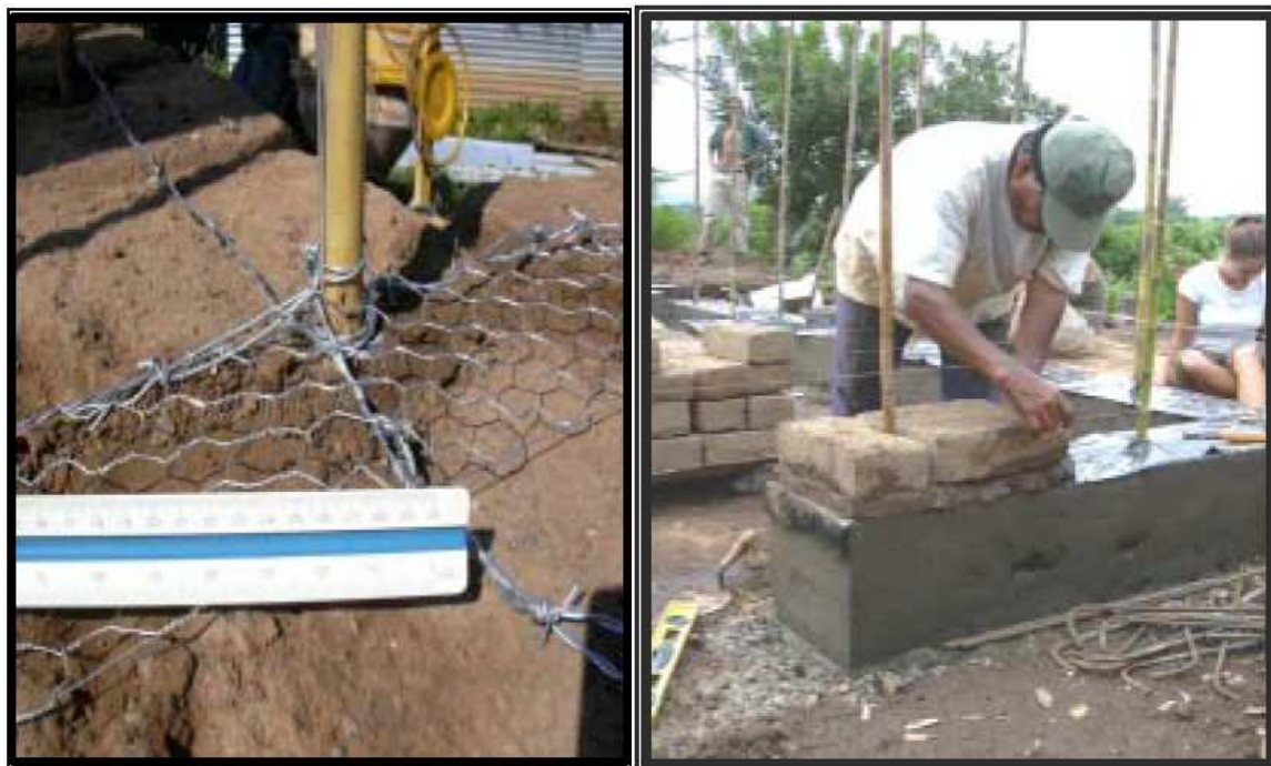
Figura 4-13 Colocación del Refuerzo de Caña en El Salvador.
