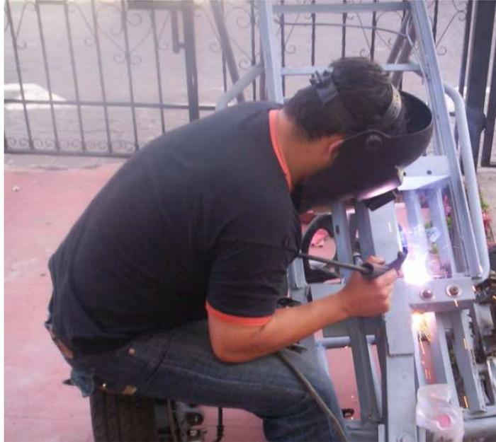
**Figura 4.1: Soldadura del bastidor**
