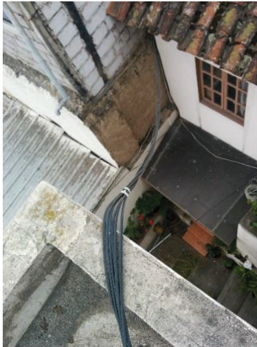
Figura 2.21 Cable FTP tendido desde el centro de operaciones hacia la torreta
