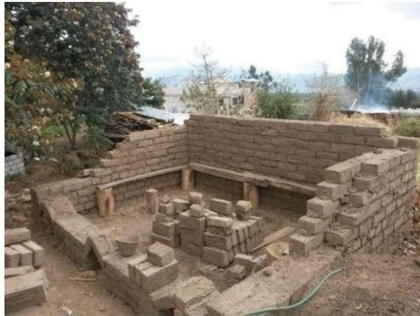
**Figura 2.3** Construcción de horno de adobe para ladrillos, Yaruquí, Pichincha.
