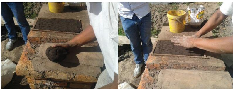
**Figura E. 5** a) Porción de la mezcla, b) Poner sobre el molde
