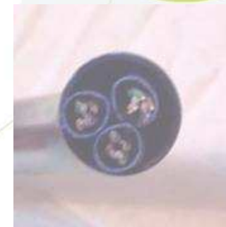
Tres Cables Cat6a en un Conduit de 0,75".
