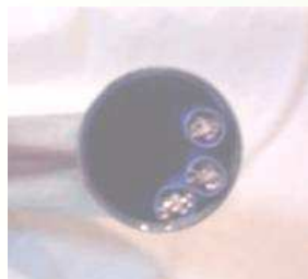
Tres cables Cat6 en un Conduit de 0,75".
