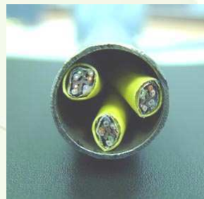
Tres cables FTP Cat6 in un Conduit de 0,75".
