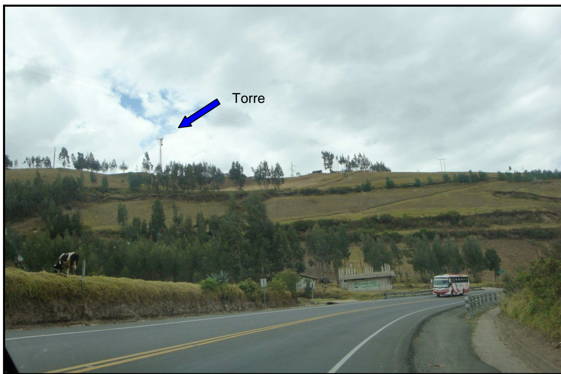
Figura No. 3.41 Entorno Radio Base Otecel Lago San Pablo
