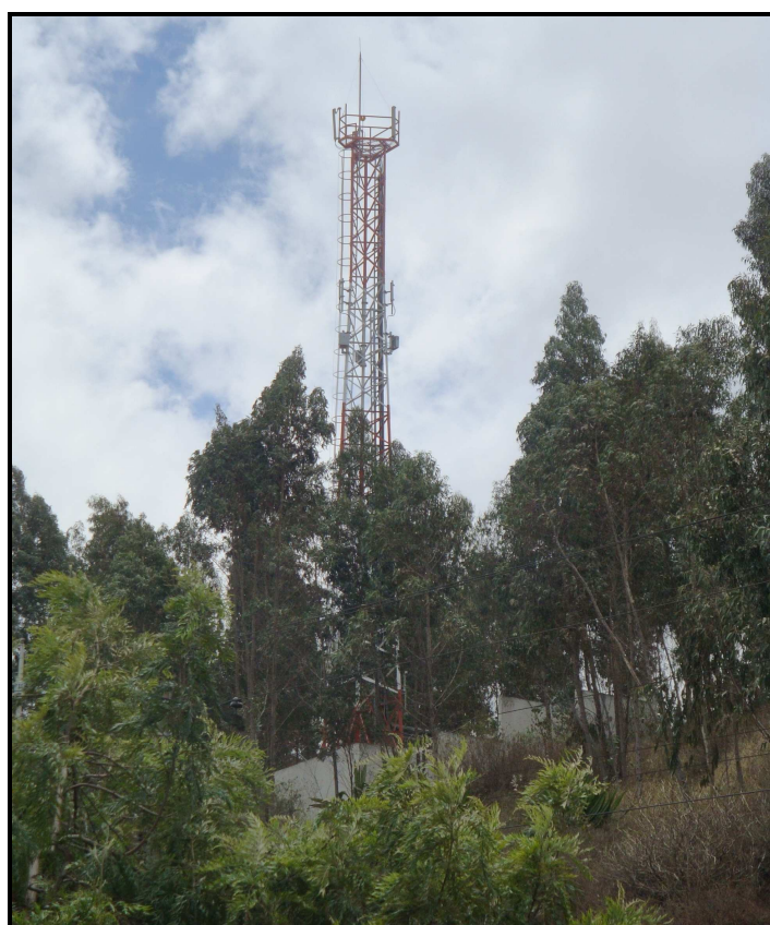
Figura No. 3.48 Ubicación Radio Base Otecel Otavalo Fuente: Autores
