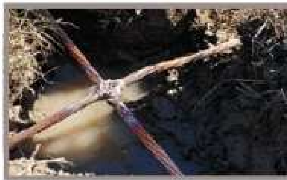
FIG 53. Obtención de la soldadura.
