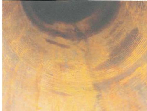
Fotografía 3.3 Área del Anclaje en el Casing 9 5/8" después de 520 toneladas de Tensión
