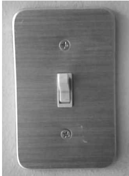
Figura 1.27 Interruptor simple empotrado en pared
