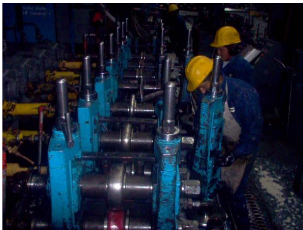
FOTOGRAFIA N° 19 Montaje de la matricería en el tren de laminación.
