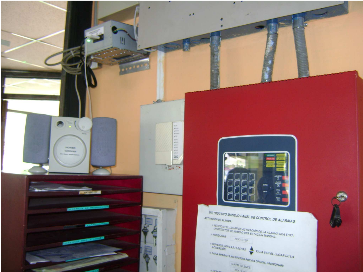
Figura 5.5 MS-9200UDLS, hardware implementado y parlantes para pruebas
