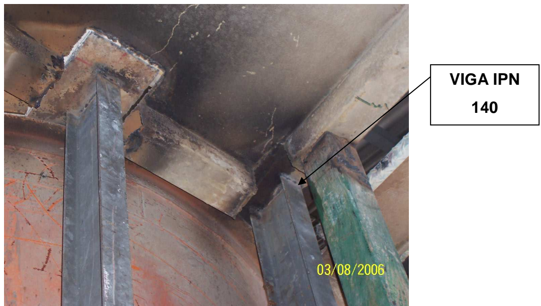
Fig.2.7 vigas de refuerzo bases del tanque
