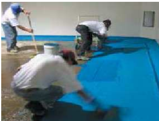
Foto 4.3. Recubrimiento epóxico de pisos
