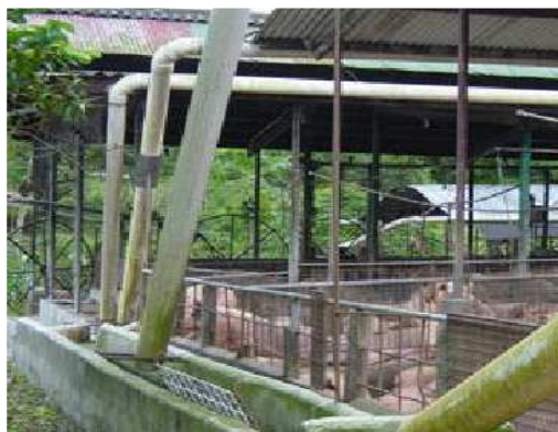
Foto 4.4. Canales para la recolección de agua lluvia de techos.
