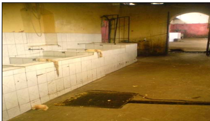
Foto 1.17. Área de lavado de vísceras posterior a su limpieza.
