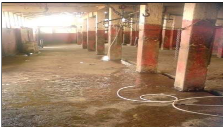
Foto 1.18. Área de faenamiento posterior a su limpieza.
