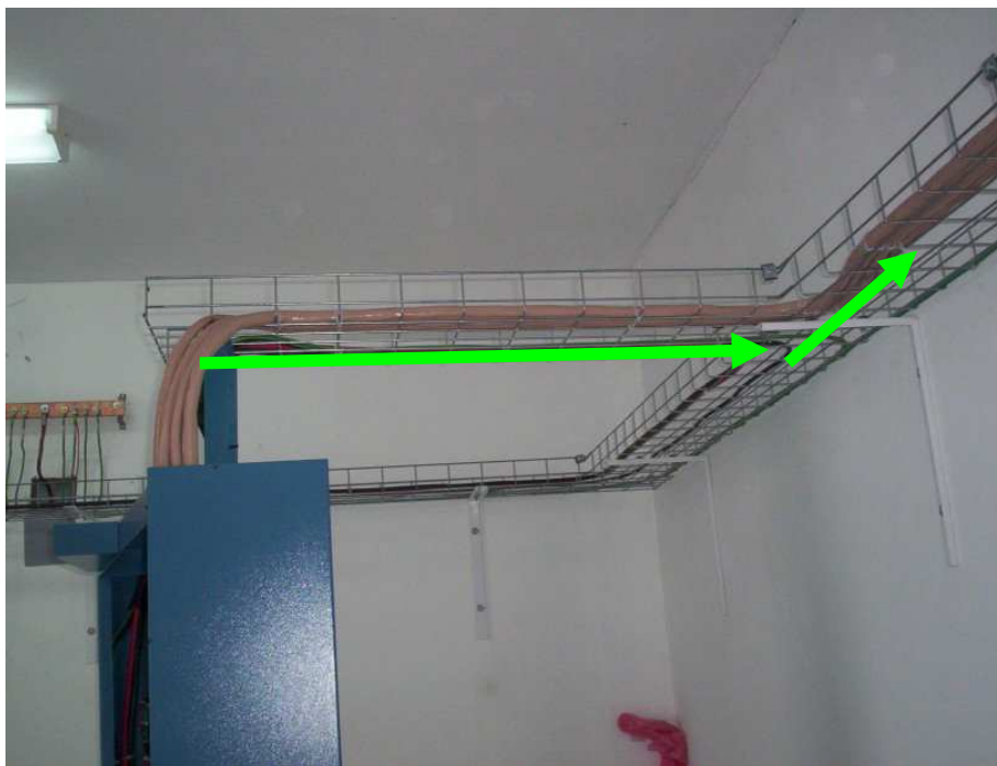
Figura: 6.10.3 Vista lateral externa del rack
