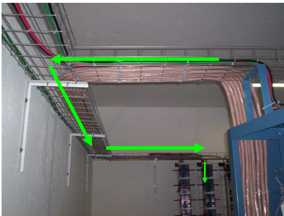
Figura: 6.10.4 Vista lateral interna del rack
