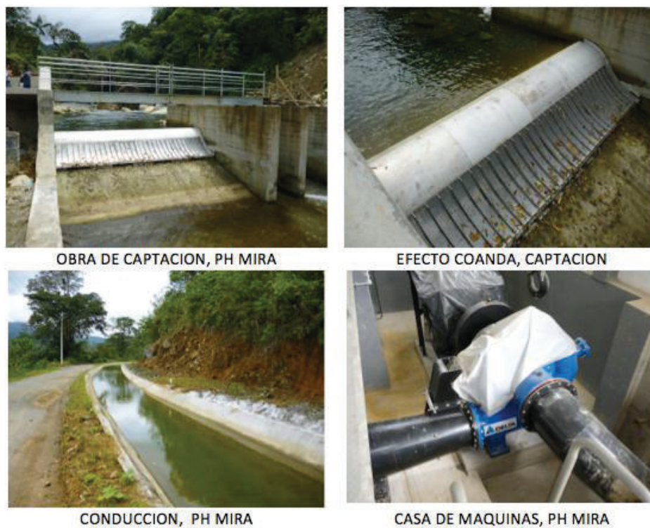
Figura 1.8 Proyecto Hidroeléctrico Mira
