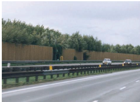
Figura 2. 15 Pantallas acústicas de madera Fuente: (Alegre & Domínguez, 2004)
