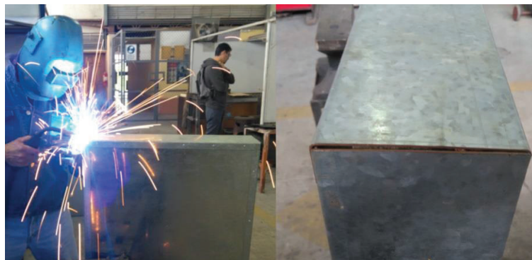
Figura 4. 8 Proceso de Soldadura del Prototipo de Pantalla Acústica
