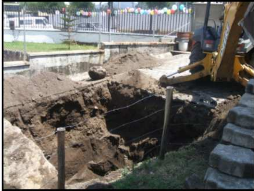
Fig. 4.20: Excavación del terreno.
