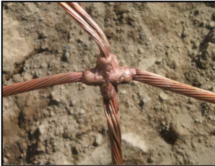
Fig. 4.26: Suelda exotérmica entre cables.
