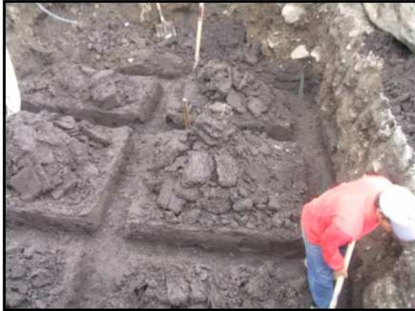
Fig. 4.22: Zanjas en donde se ubicó la malla de puesta a tierra.
