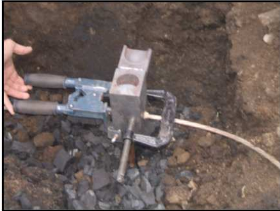
Fig. 4.24: Procedimiento de la soldadura exotérmica.
