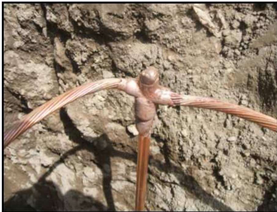
Fig. 4.25: Suelda exotérmica entre la varilla y el cable.
