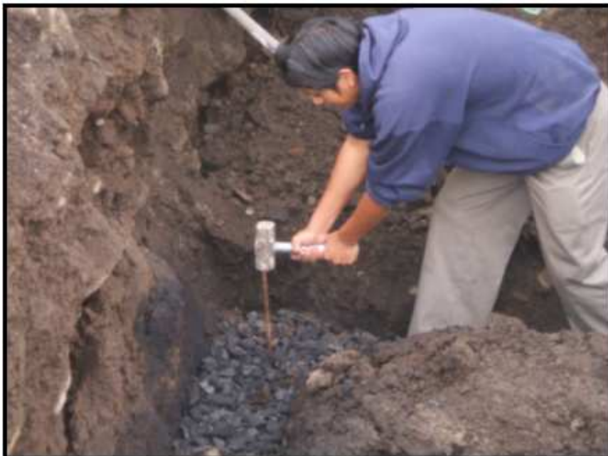
Fig. 4.23: Instalación de las varillas copperweld.
