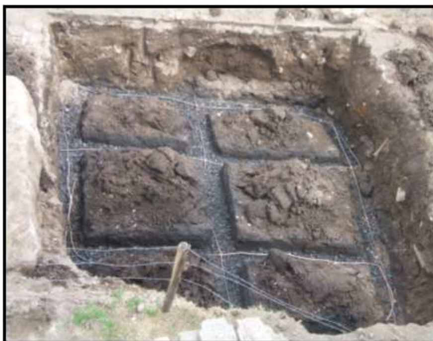
Fig. 4.27: Malla terminada. Instalada a 1m de profundidad.
