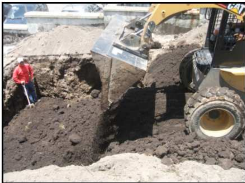
Fig. 4.21: Relleno de dos metros con la tierra preparada.
