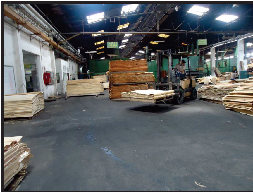
FOTOGRAFÍA 2. 1 PISO INDUSTRIAL TRÁNSITO VEHICULAR
