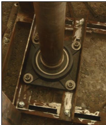
**Figura 2.18** Perfiles soporte de chumacera instalado durante la construcción del Proyecto
