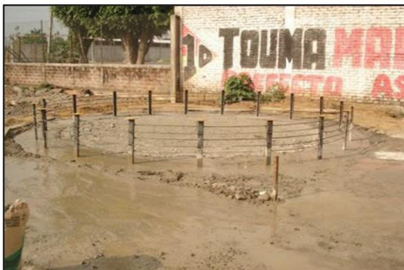
**Figura 2.5** Fundición de plintos y cimientos realizada en la construcción del Proyecto
