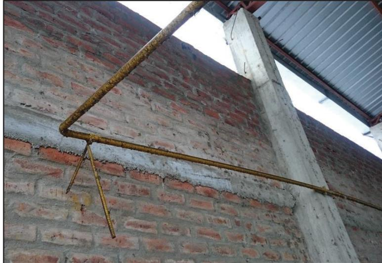
**Figura 2.35** Tubería instalada del gas centralizado.
