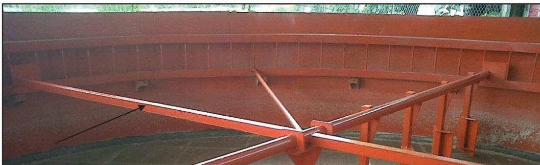
**Figura 2.24** Eje transversal cuadrado instalado durante la construcción del Proyecto
