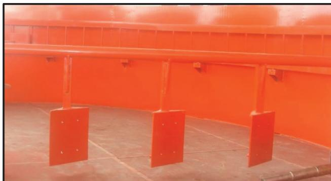
**Figura 2.22** Eje portapaletas instalado durante la construcción del Proyecto
