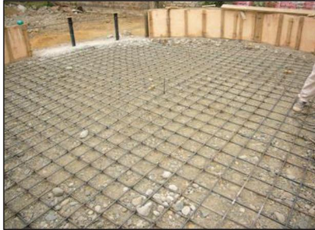
**Figura 2.8** Malla electrosoldada colocada en el piso durante la construcción del Proyecto
