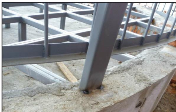
**Figura 2.13** Soportes verticales colocados en el muro durante la construcción del Proyecto
