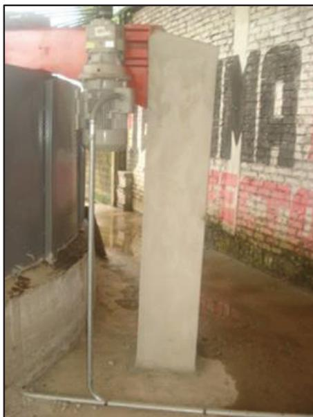
**Figura 2.26** Columna soporte cimentada durante la construcción del Proyecto
