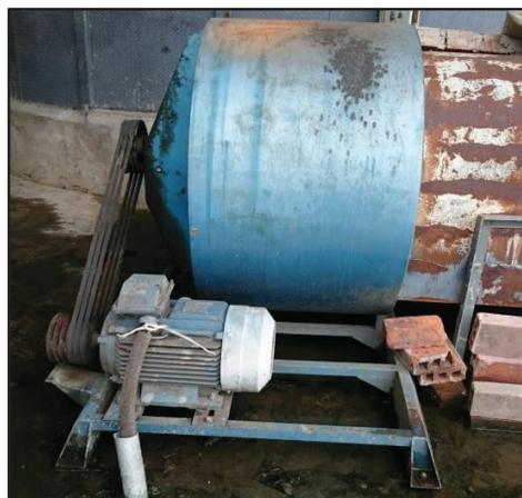
**Figura 2.34** Motor del ventilador para el quemador.
