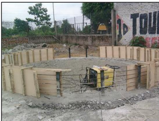
**Figura 2.6** Encofrado para el muro realizado en la construcción del Proyecto
