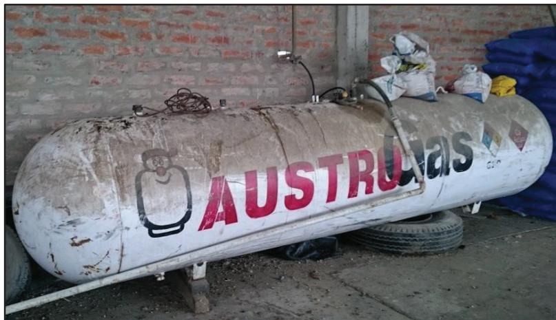
**Figura 2.36** Tanque de almacenamiento de gas.
