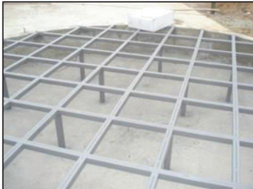
**Figura 2.10** Estructura del piso del secador colocado durante la construcción del Proyecto
