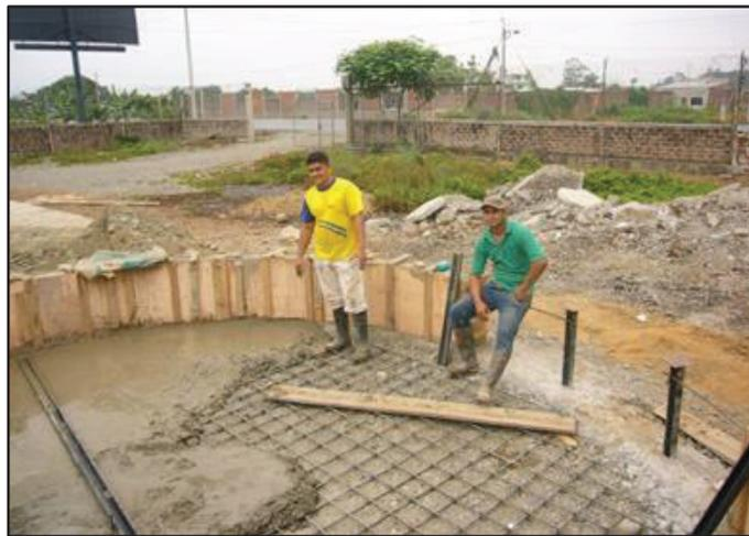
**Figura 2.9** Fundición del piso del secador durante la construcción del Proyecto
