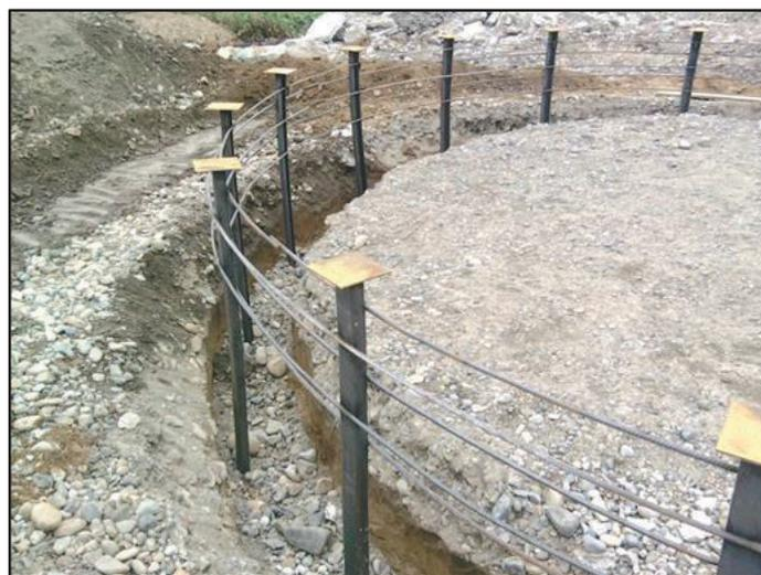
**Figura 2.3** Excavación de plintos y cimientos realizada en la construcción del Proyecto
