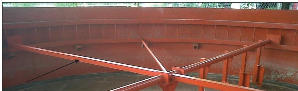
**Figura 2.29** Eje transversal cuadrado instalado durante la construcción del Proyecto
