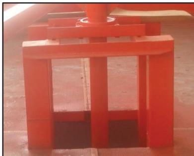
**Figura 2.17** Estructura soporte del eje central instalado durante la construcción del Proyecto
