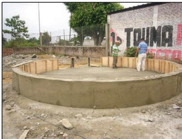
**Figura 2.7** Fundición de muro realizada en la construcción del Proyecto
