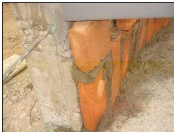
**Figura 2.11** Ladrillo refractario colocado en la pared interna del secador, durante la construcción del Proyecto
