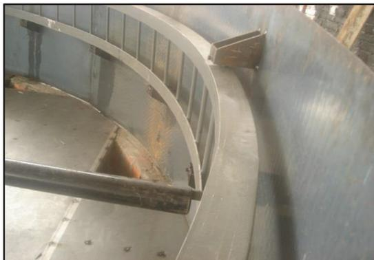
**Figura 2.14** Plancha barolada de la pared del secador instalada durante la construcción del Proyecto
