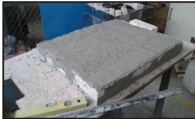
Figura 3.7. Construcción del techo del horno.
