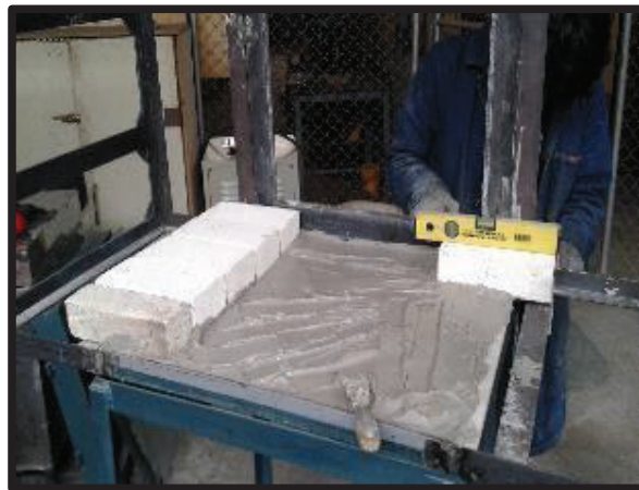
Figura 3.4. Construcción de la solera del horno.
