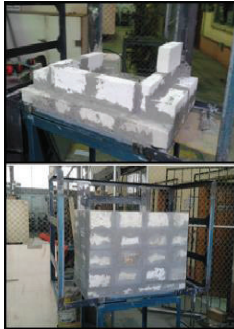
Figura 3.5. Construcción de las paredes del horno.
