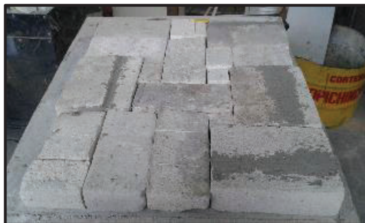
Figura 3.6. Disposición de los ladrillos en el techo del horno.
