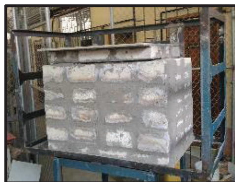
Figura 3.8. Montaje del techo del horno
