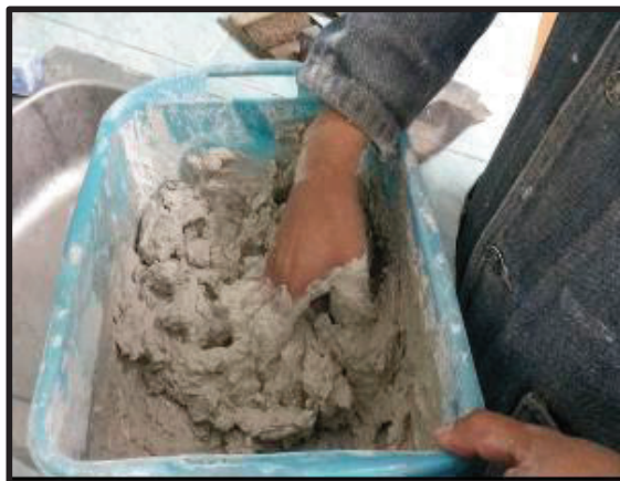
Figura 3.11. Preparación de la mezcla de Cóncrax 1500 y agua.
