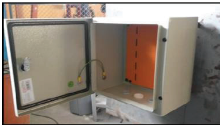
Figura 3.23. Instalación de la caja de elementos de regulación
