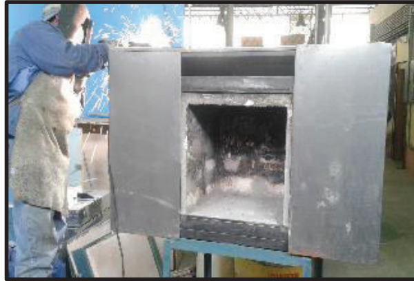
Figura 3.18. Montaje de la cubierta metálica superior.
