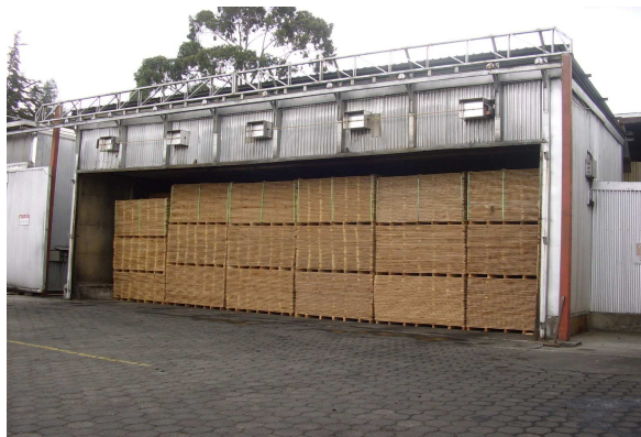
Figura 1.1.8 Cámaras de secado de producto
