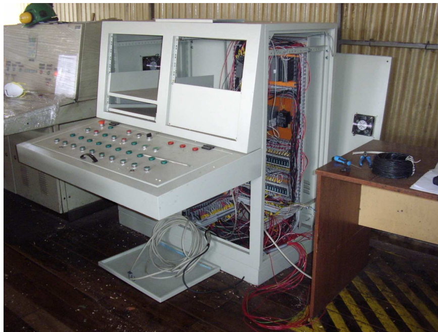
Figura 5.9 Traslado del nuevo tablero de mando al sitio de funcionamiento
