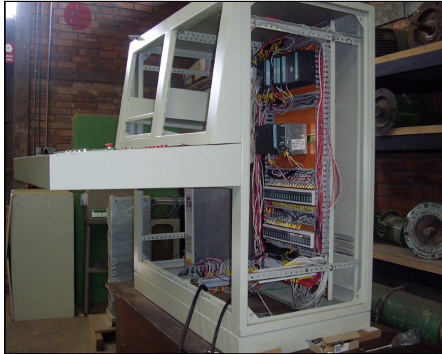
Figura 5.4 Colocación y conexión de elementos en el tablero de mando
