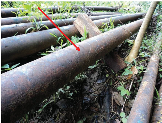
Fotografía 3.16c. Condición de la tubería en sitio
