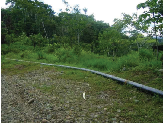
Fotografía 3.12a. Ubicación en sitio
