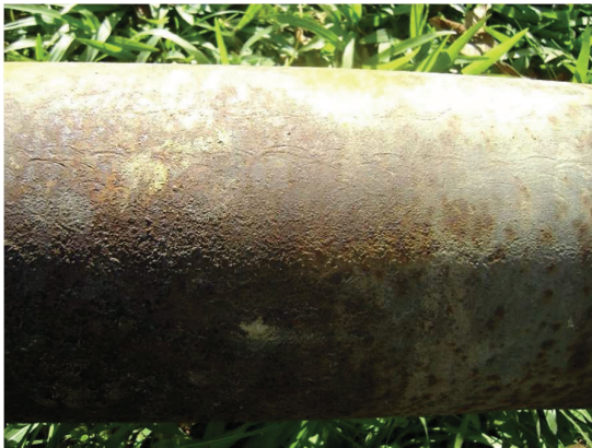
Fotografía 3.3c. Condición de la tubería en sitio
