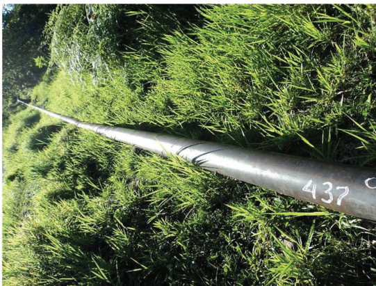
Fotografía 3.10c. Condición de la tubería en sitio
