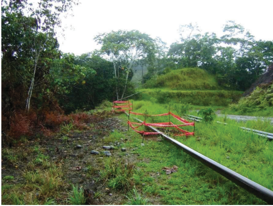
Fotografía 3.10a. Ubicación en sitio
