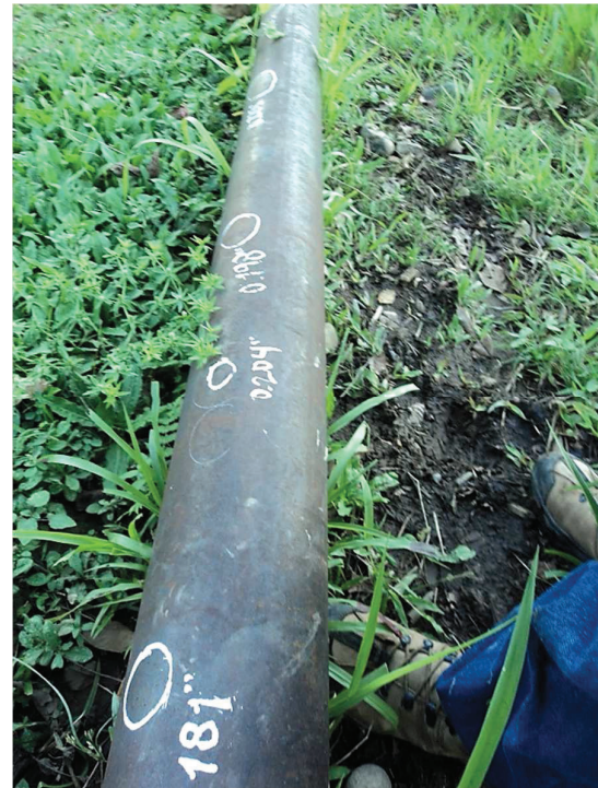
Fotografía 3.9d. Condición de la tubería en sitio
