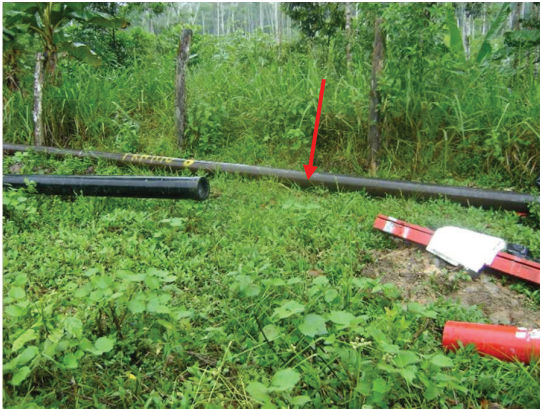
Fotografía 3.6a. Ubicación en sitio
