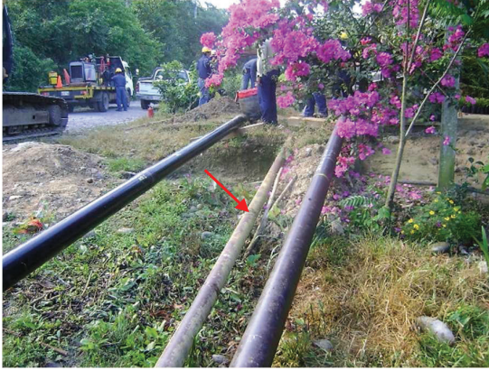
Fotografía 3.1a. Ubicación en sitio
