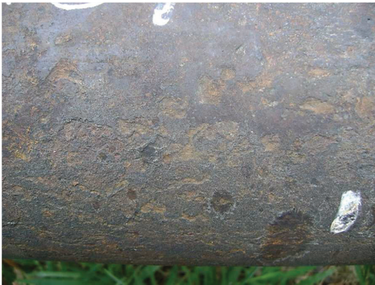
Fotografía 3.2c. Condición de la tubería en sitio
