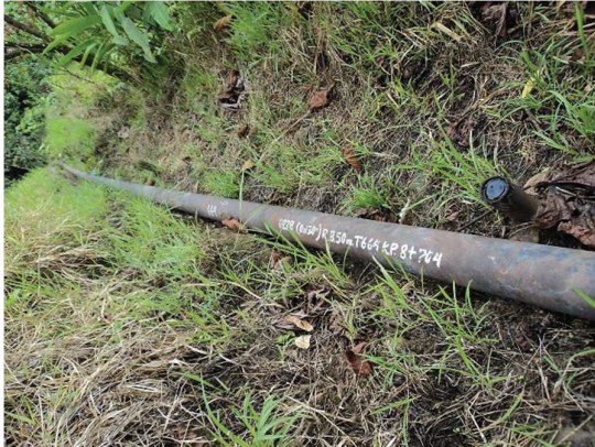
Fotografía 3.14a. Ubicación en sitio
