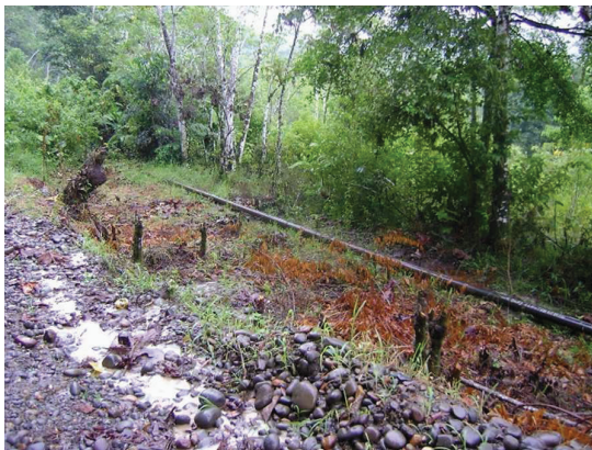
Fotografía 3.13a. Ubicación en sitio
