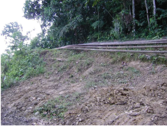
Fotografía 3.16a. Ubicación en sitio
