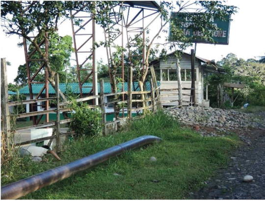
Fotografía 3.7c. Condición de la tubería en sitio
