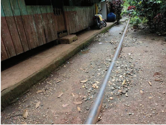
Fotografía 3.11a. Ubicación en sitio
