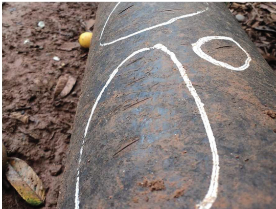
Fotografía 3.11c. Condición de la tubería en sitio
