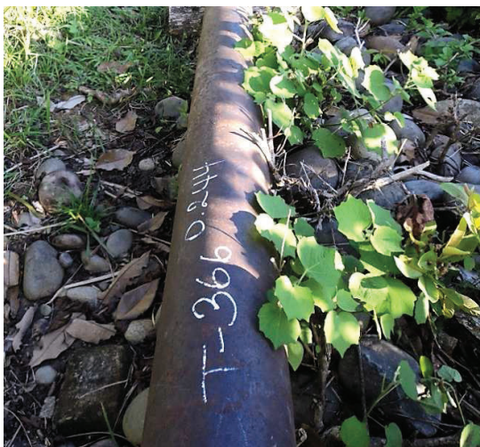
Fotografía 3.6c. Condición de la tubería en sitio
