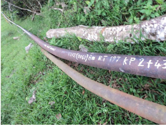
Fotografía 3.2a. Ubicación en sitio
