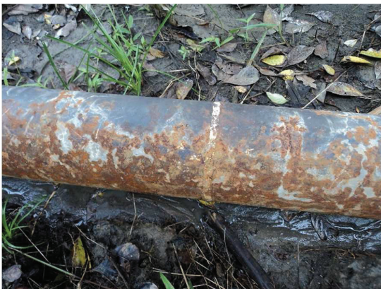
Fotografía 3.13c. Condición de la tubería en sitio
