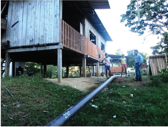
Fotografía 3.3a. Ubicación en sitio
