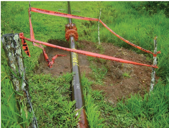
Fotografía 3.8c. Condición de la tubería en sitio
