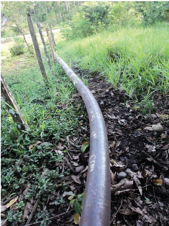
Fotografía 3.9c. Condición de la tubería en sitio
