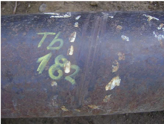
Fotografía 3.1c. Condición de la tubería en sitio
