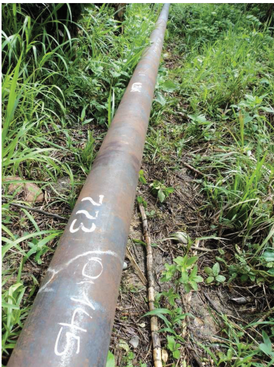
Fotografía 3.15a. Condición de la tubería en sitio
