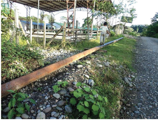
Fotografía 3.7a. Ubicación en sitio
