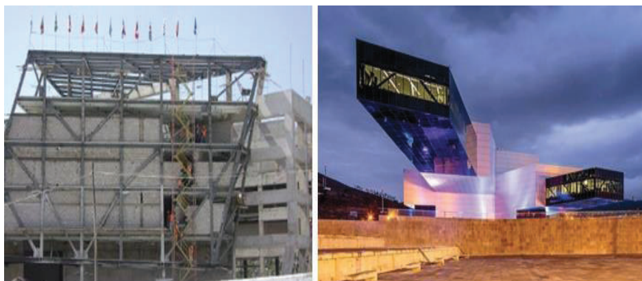
Figura 34. Edificio de UNASUR, etapa constructiva febrero 2014
