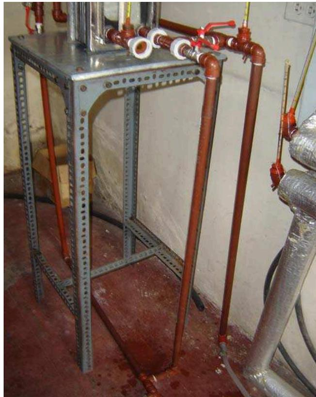
**Figura 4.4 Tubería, acoples y accesorios, sistema de agua fría**
