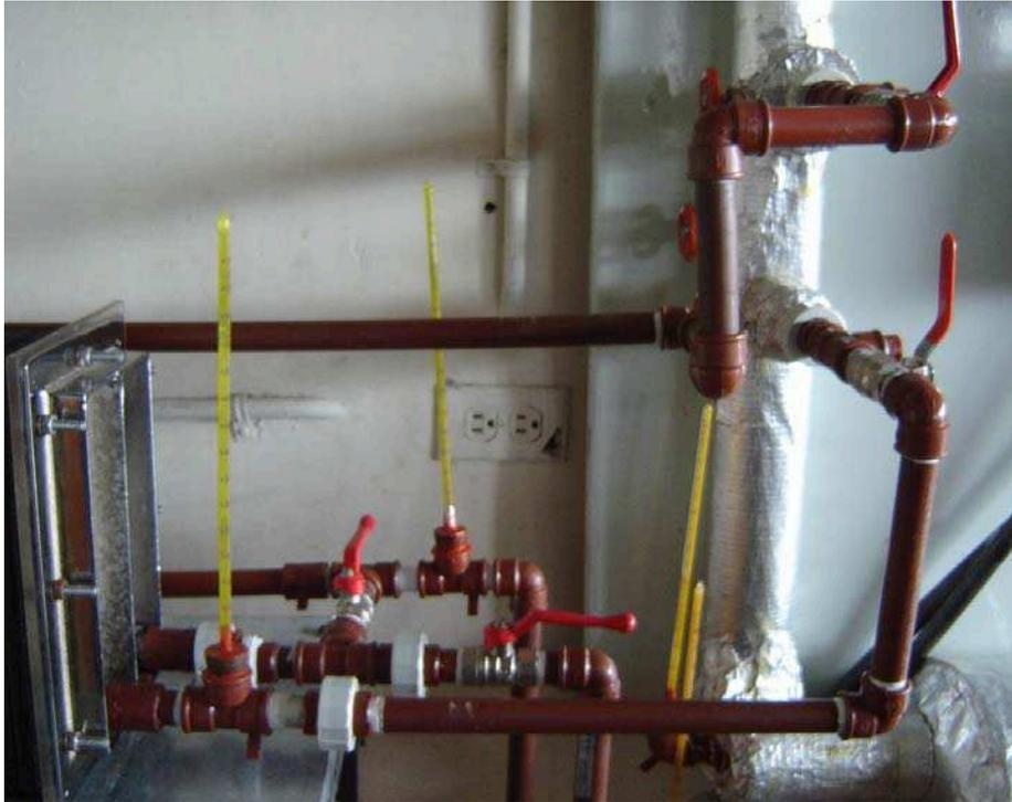
**Figura 4.3 Tubería, acoples y accesorios, sistema de agua caliente**
