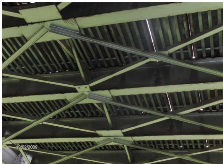
Figura 4. 10 Tableros Tipo de acero que conforman el emparrillado del puente
