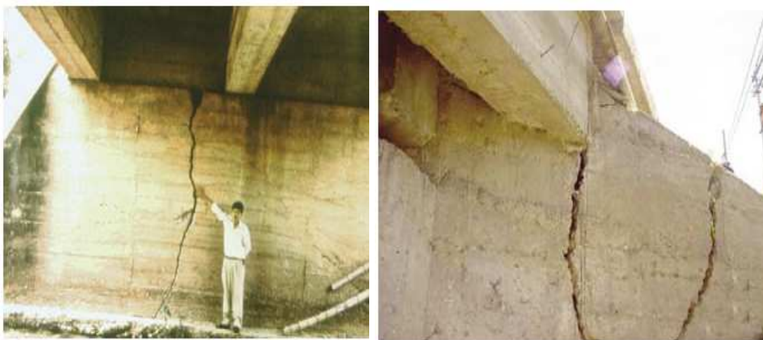
Figura 2. 16 a) Grieta en estribo por socavación de la cimentación superficial y la falta de capacidad de carga. b) Grietas en la aleta por asentamientos y socavación.
