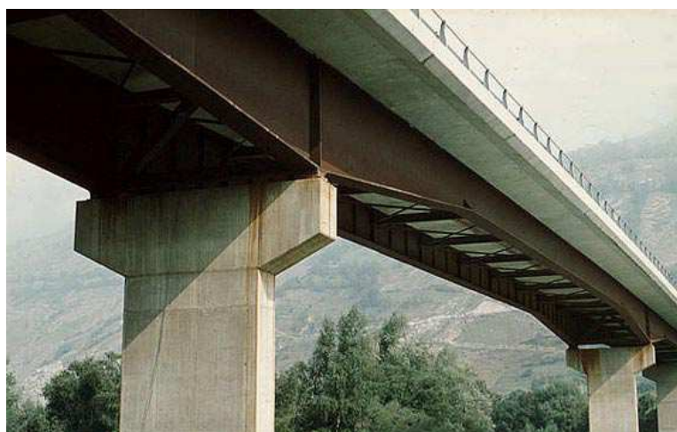
Figura 1. 19 Puente Tipo Mixto (Hormigón – Acero)
