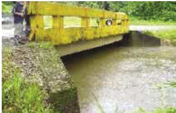
Figura 2. 19 Agradación progresiva con posibilidades de subemergencia.
