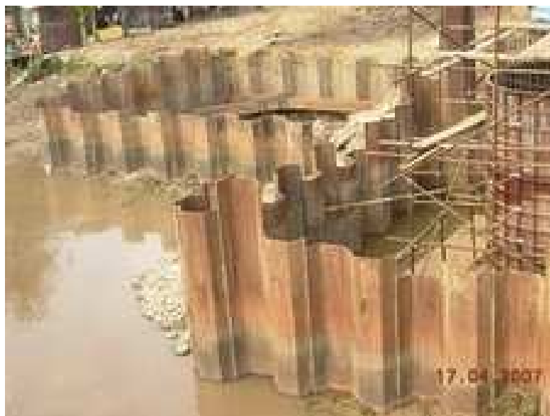
Figura 4.7 Recintos estancos para recimentación de pilas
