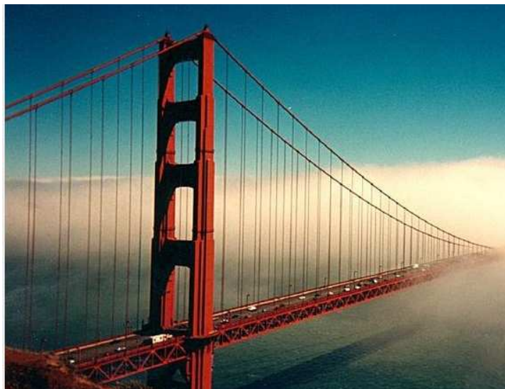
Figura 1. 4 Puente Tipo Colgante
