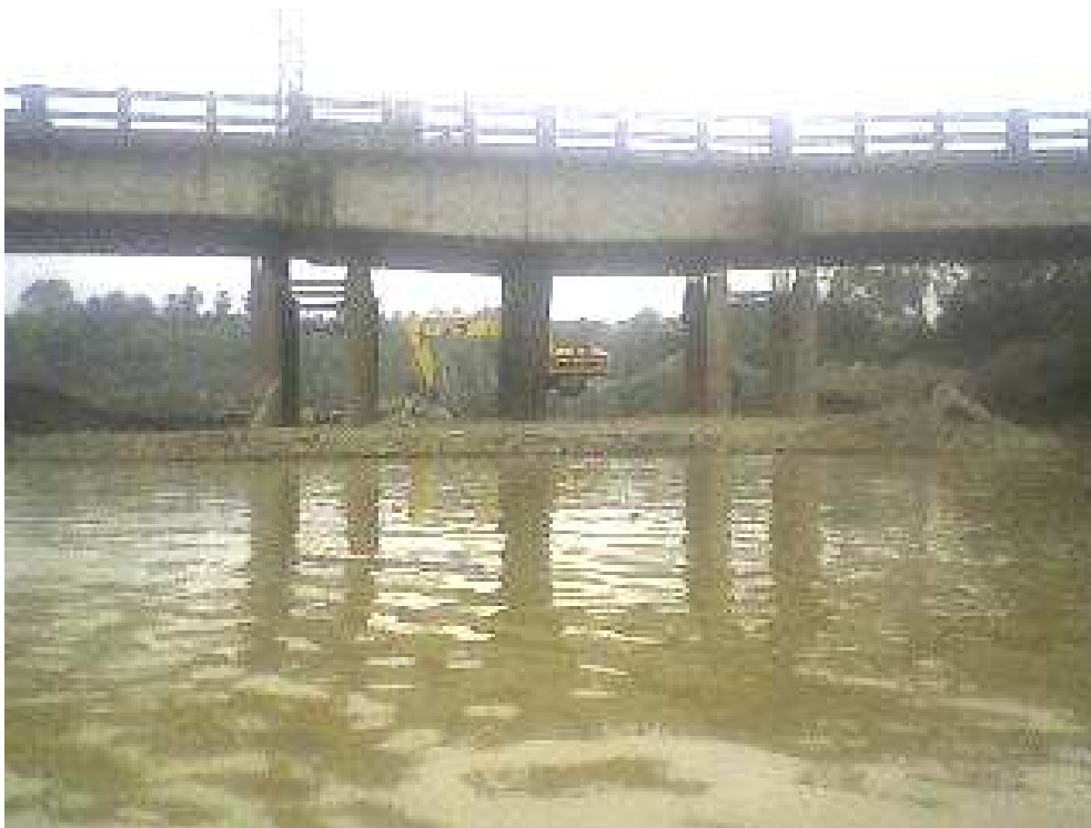
Figura 4. 4 Vista longitudinal de la pila asentada, noviembre 2008
