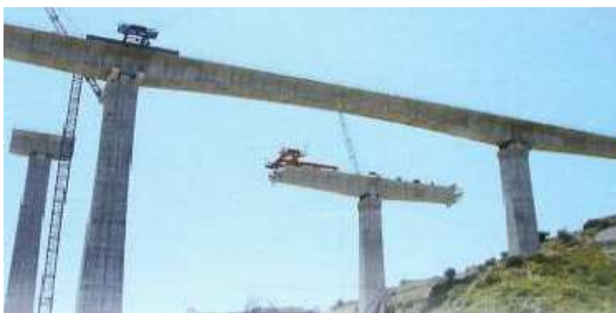
Figura 5. 9 Lanzamiento por Obra Falsa de dovelas Tipo
