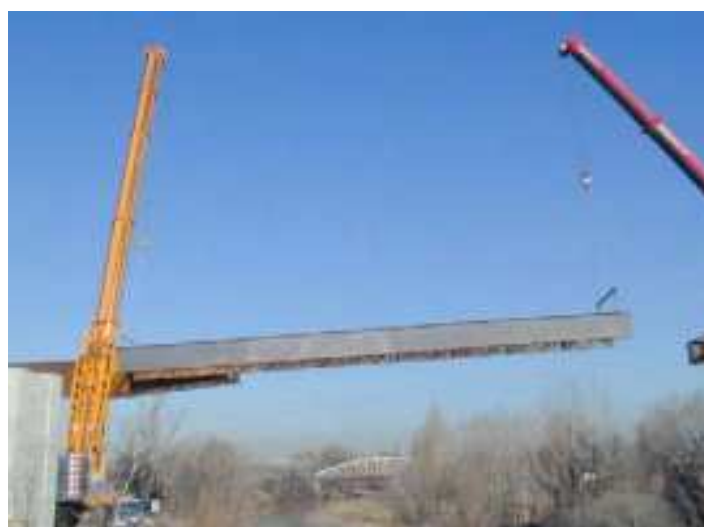
Figura 5. 10 Montaje de grúa de una dovela tipo
