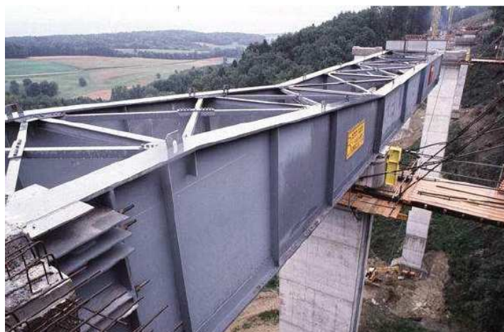
Figura 5.6 Nariz de lanzamiento tipo
