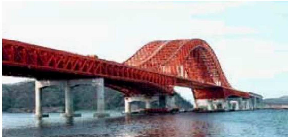
Figura 1. 9 Puente Tipo Armadura de paso inferior
