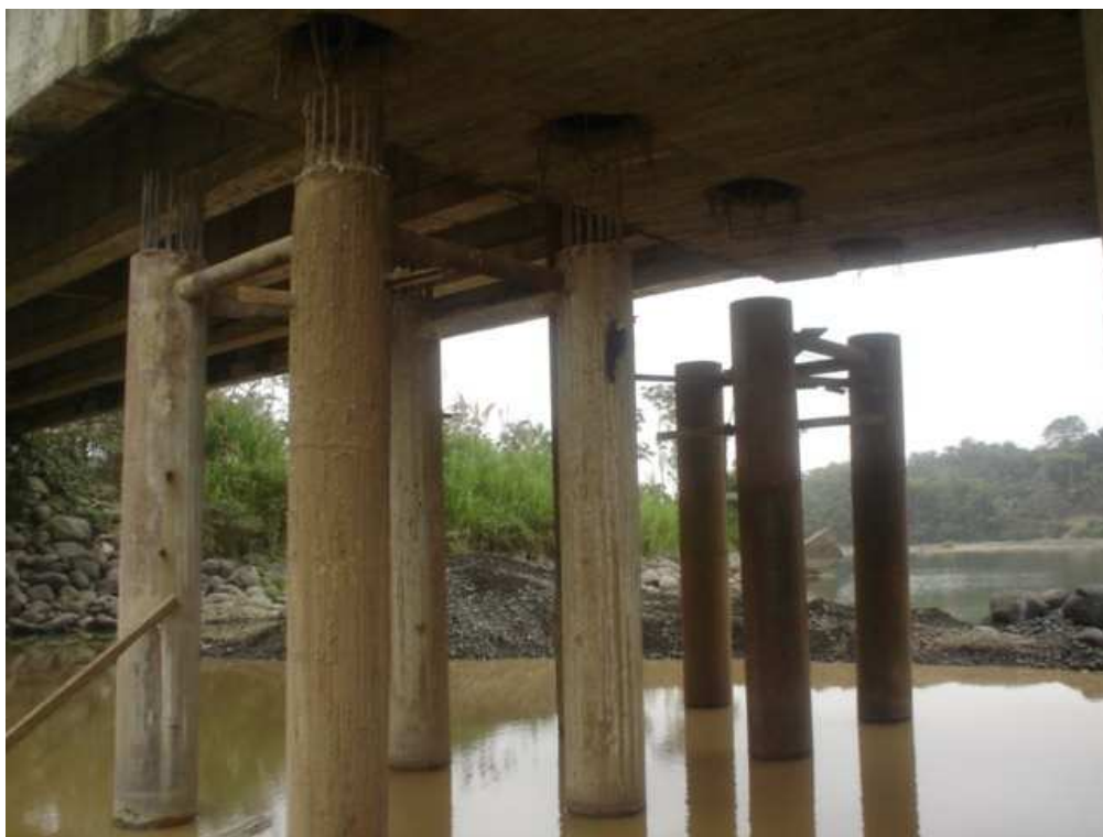
Figura 4.3 Pilotaje realizado por el MTOP, noviembre 2008.
