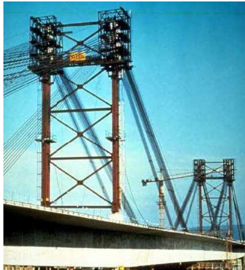
Figura 5. 11 Lanzamiento rigidizado con tirantes.
