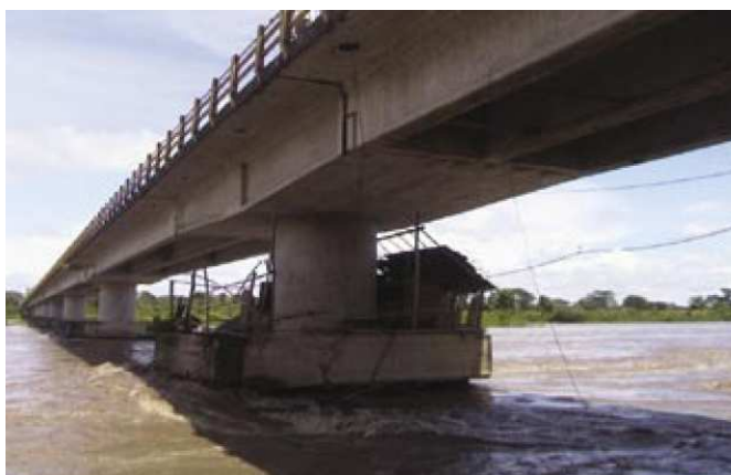
Figura 2. 23 Características Tipo de flujo alrededor de una pila
