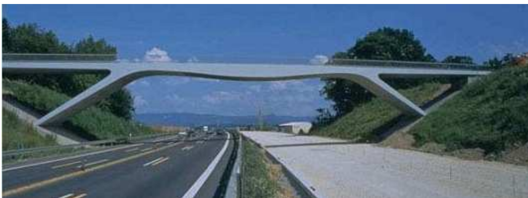
Figura 1.8 Puente Tipo en Pórtico
