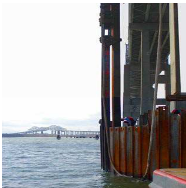
Figura 4.8 Sheet Pile o tablestacados en pilas
