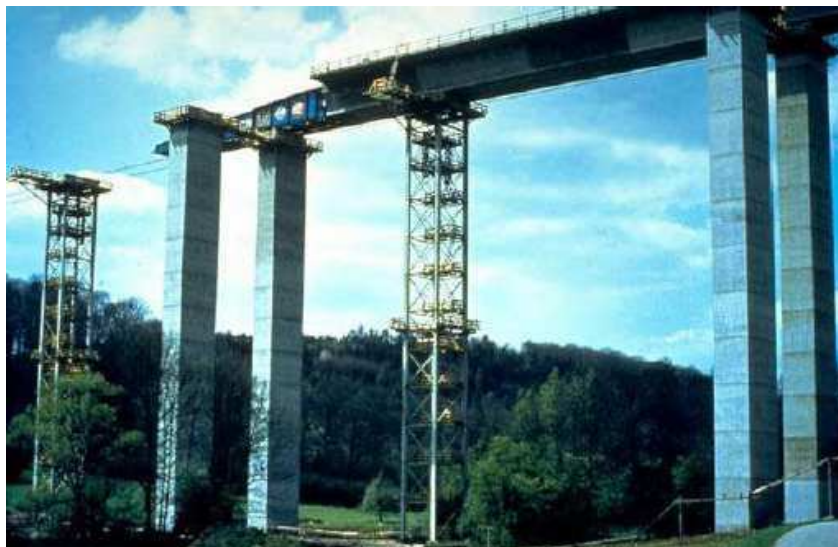
Figura 5. 8 Ejemplo de las pilas auxiliares para el lanzamiento por Obra Falsa.
