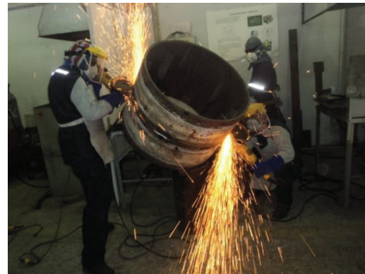
b) limpieza y remoción de escoria
