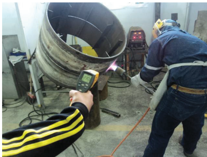
Figura 3.7 Pre calentamiento para la realización de la soldadura
