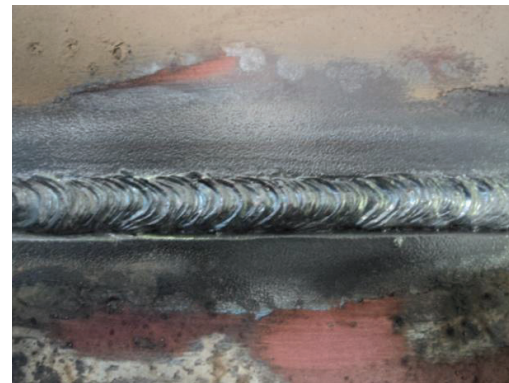
d) cordón terminado
