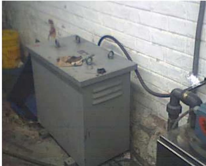
Fig. 15 Transformador (F) principal de la prensa Gazelle.
