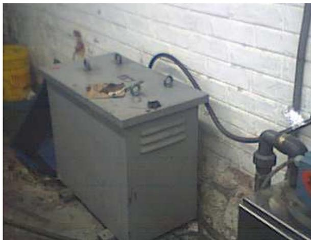
Fig.36 Transformador principal F de la prensa Gazella.
