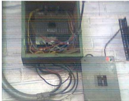
Fig.34 Protección eléctrica principal, montada en caja de madera.
