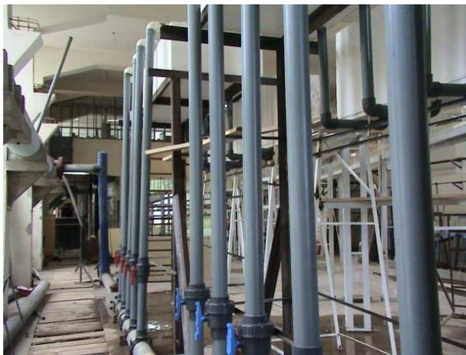
FOTOGRAFÍA N° 3.1 Conexión del modelo al sistema de distribución de agua del Laboratorio
