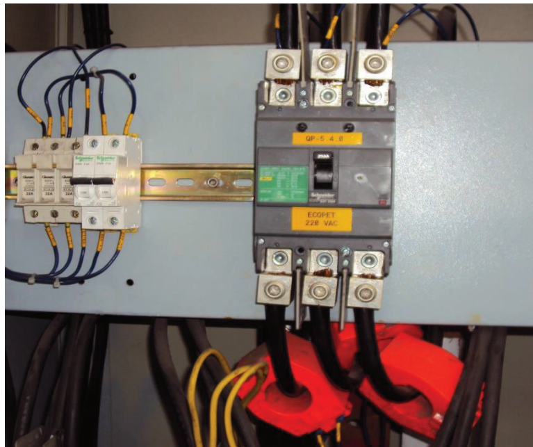
Figura 3.7 Instalación de TCs y fusibles para señales de voltaje
